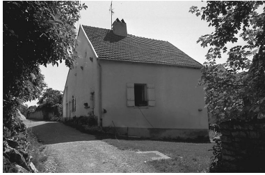
Vue d'ensemble. Phot. Bernard Lardière IVR43_19817000165Z
