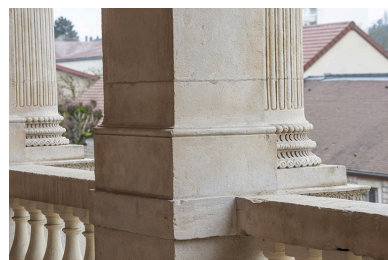
Loggia : base d'un pilier et de colonnes. Les balustres du garde-corps sont en fonte. Phot. Jérôme Mongreville IVR43_20223900201NUC4A
