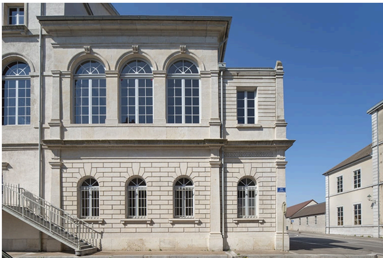
Corps d'entrée : façade latérale gauche.
