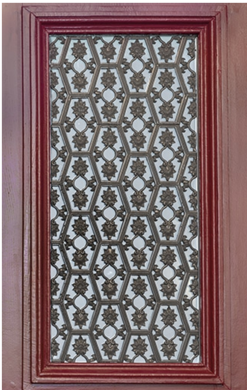
Vestibule, porte côté cour : grille en fonte.
