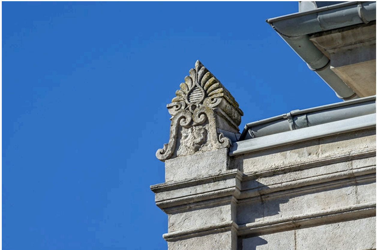
Façade antérieure : motif d'amortissement.
