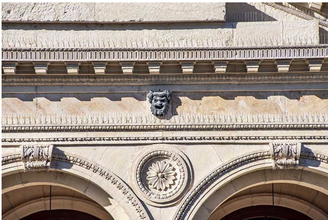
Façade antérieure, étage : décor.
