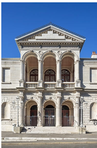
Façade antérieure : travées centrales.
