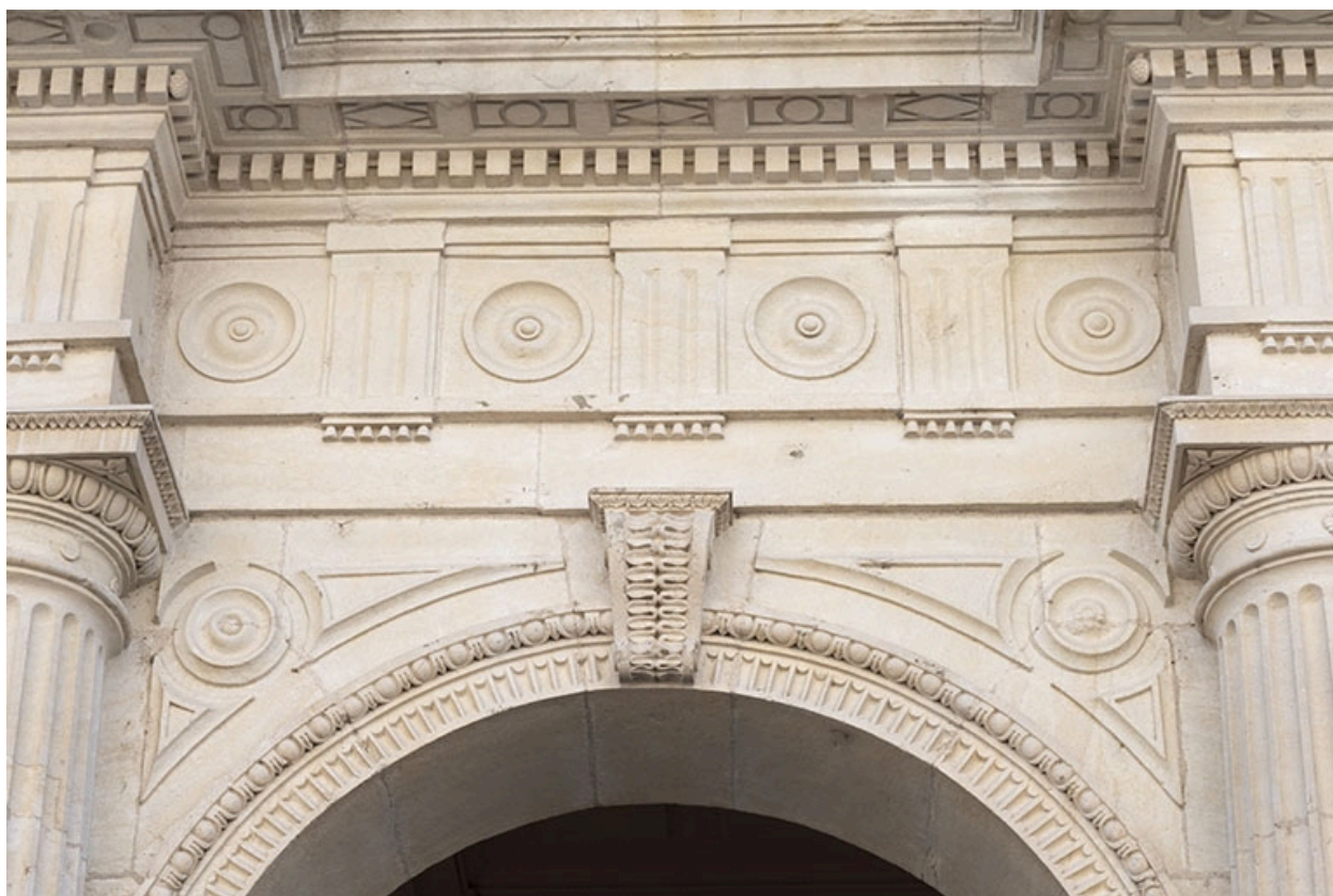
Façade antérieure, rez-de-chaussée : entablement.
