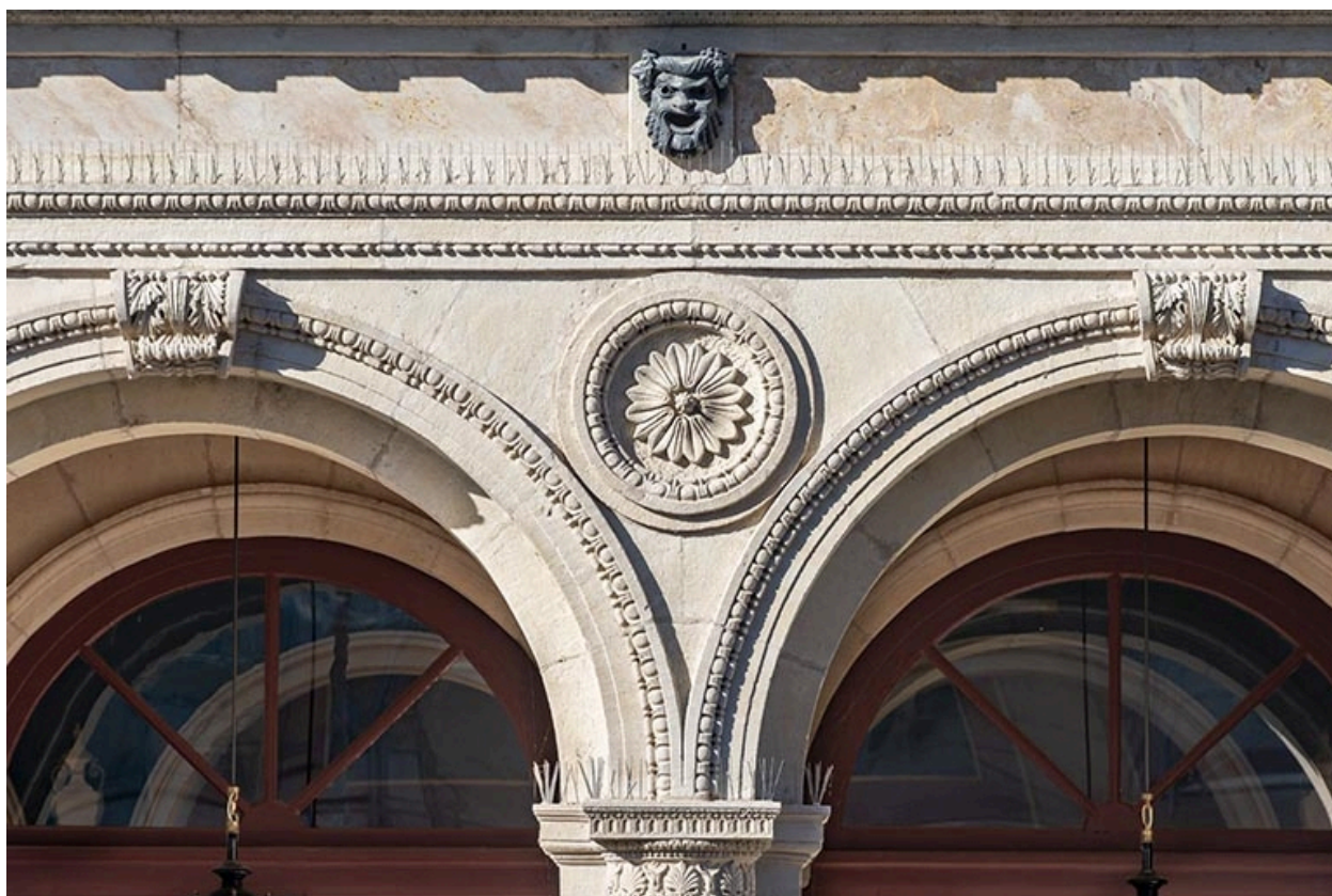
Façade antérieure, étage : décor.
