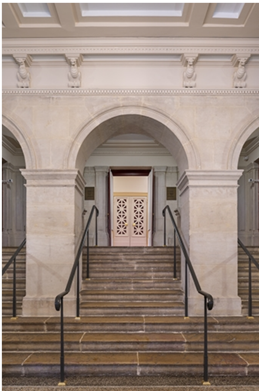
Vestibule : travée centrale de l'escalier.
