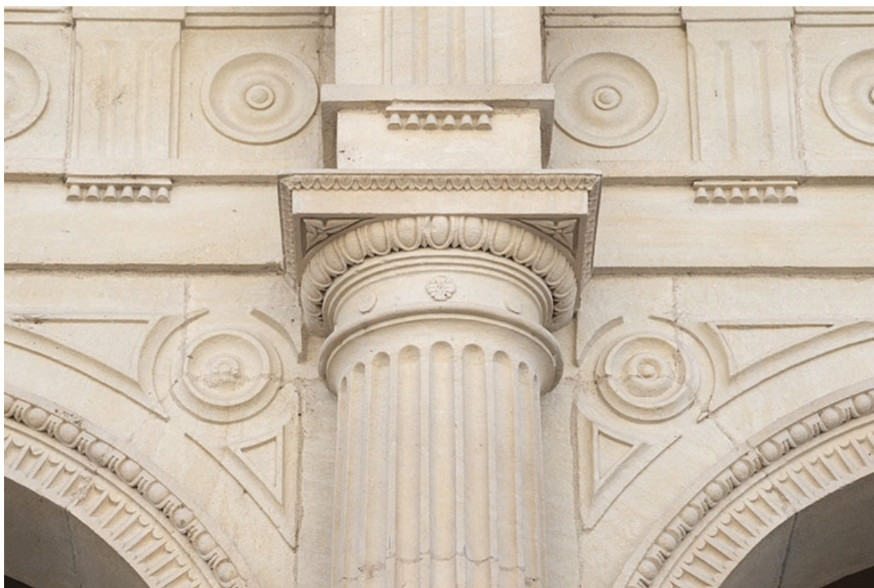
Façade antérieure, rez-de-chaussée : chapiteau dorique.
