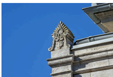
Façade antérieure : motif d'amortissement.
