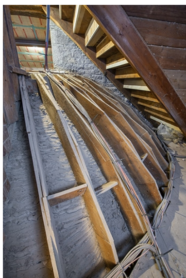
Foyer : extrados de la fausse-voûte en cul-de-four de l'antichambre (côté jardin), dans le comble. Phot. Jérôme Mongreville IVR43_20223900266NUC4A
