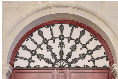
Vestibule, porte côté cour : grille en fonte du tympan. Phot. Jérôme Mongreville IVR43_20223900163NUC4A
