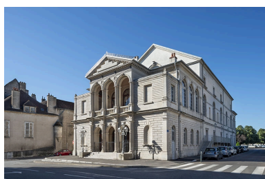
Façades antérieure et latérale droite.
