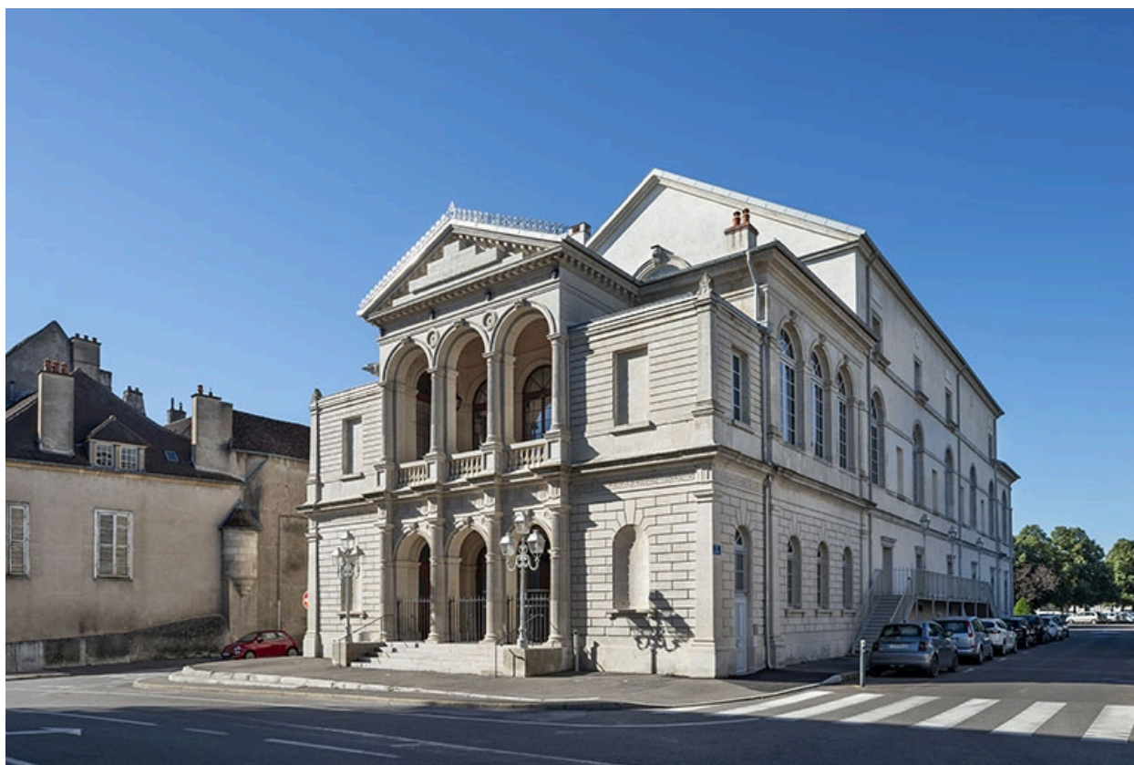
Façades antérieure et latérale droite.
