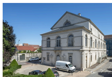
Façades postérieure et latérale gauche.
