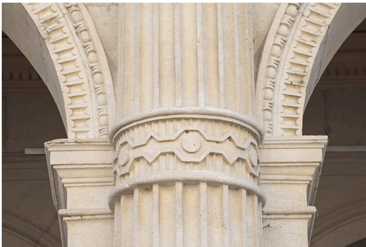
Façade antérieure, rez-de-chaussée : bague de colonne.
