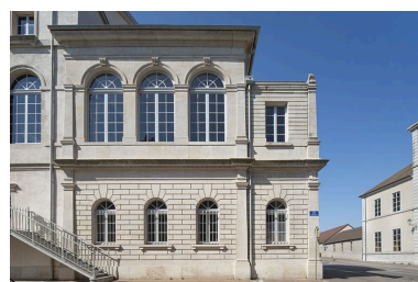
Corps d'entrée : façade latérale gauche.
