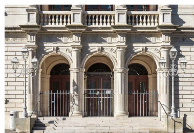
Façade antérieure : baies du rez-de-chaussée.
