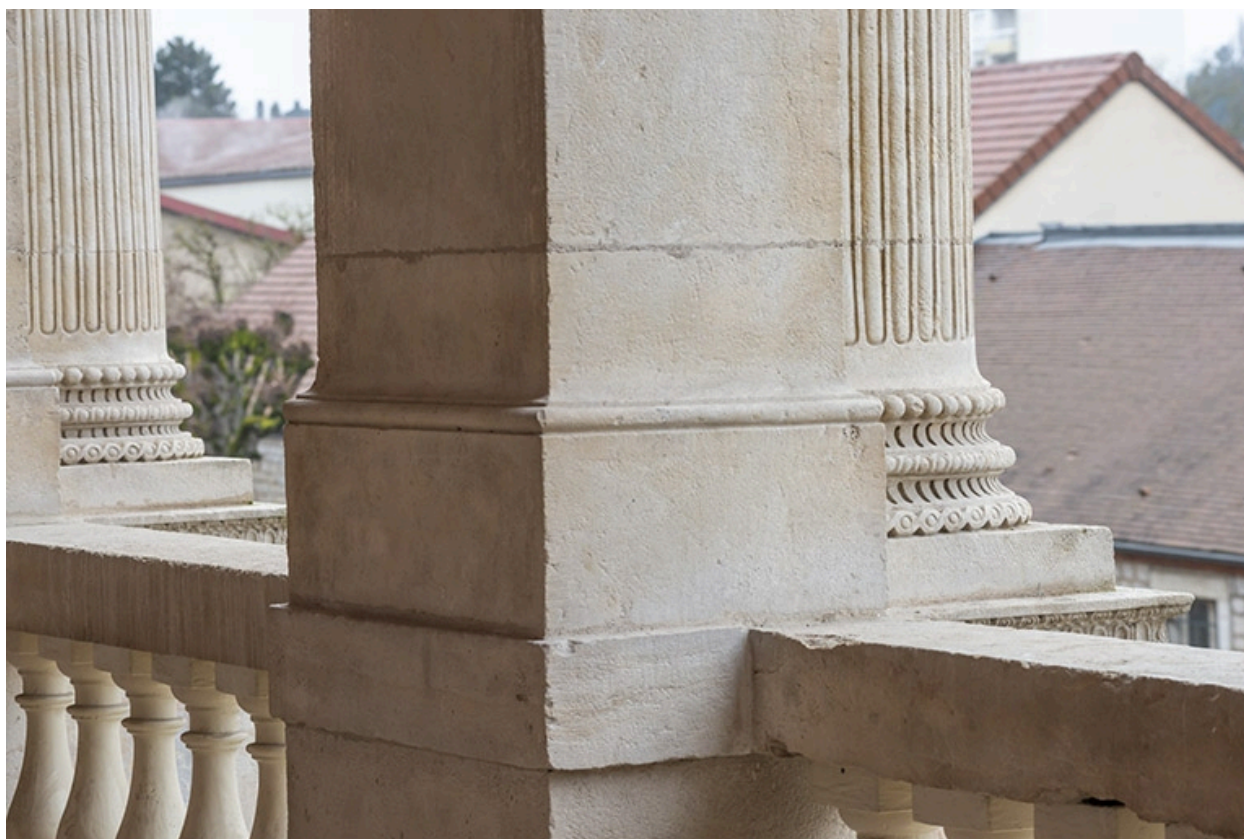
Loggia : base d'un pilier et de colonnes. Les balustres du garde-corps sont en fonte.
