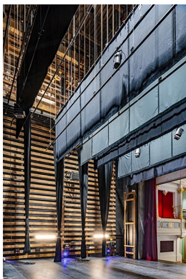
Cage de scène : cheminée de contrepoids côté cour, pendrillons et frises. Phot. Jérôme Mongreville
