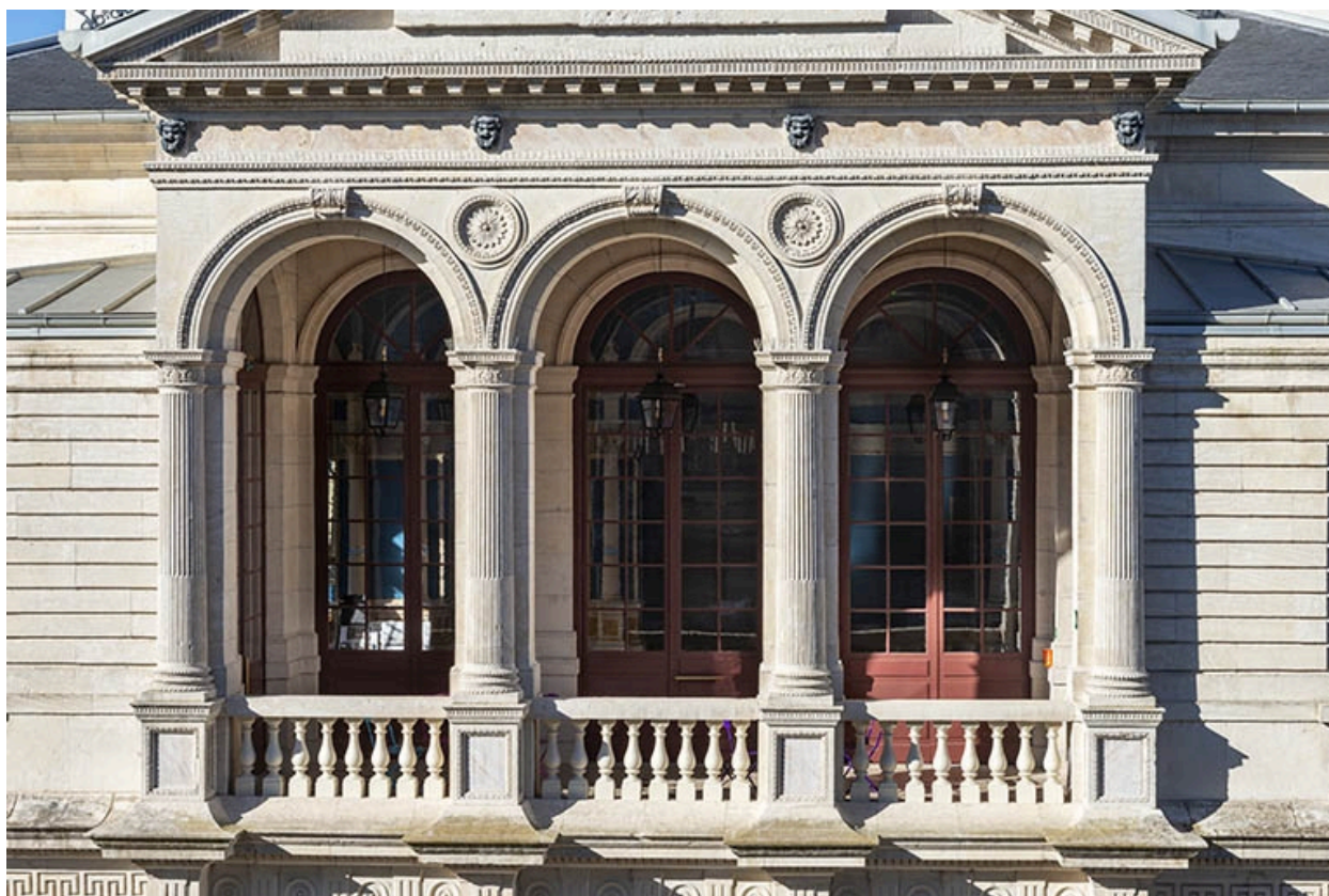
Façade antérieure, étage : baies de la loggia.
