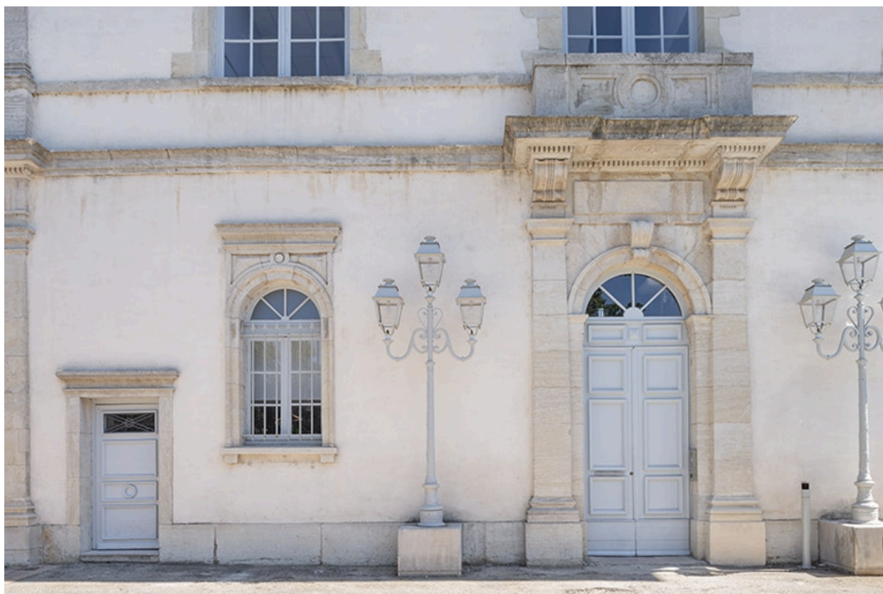
Façade postérieure : baies au rez-de-chaussée.
