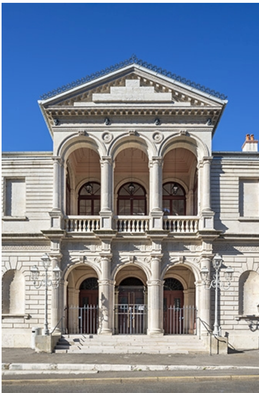
Façade antérieure : travées centrales.
