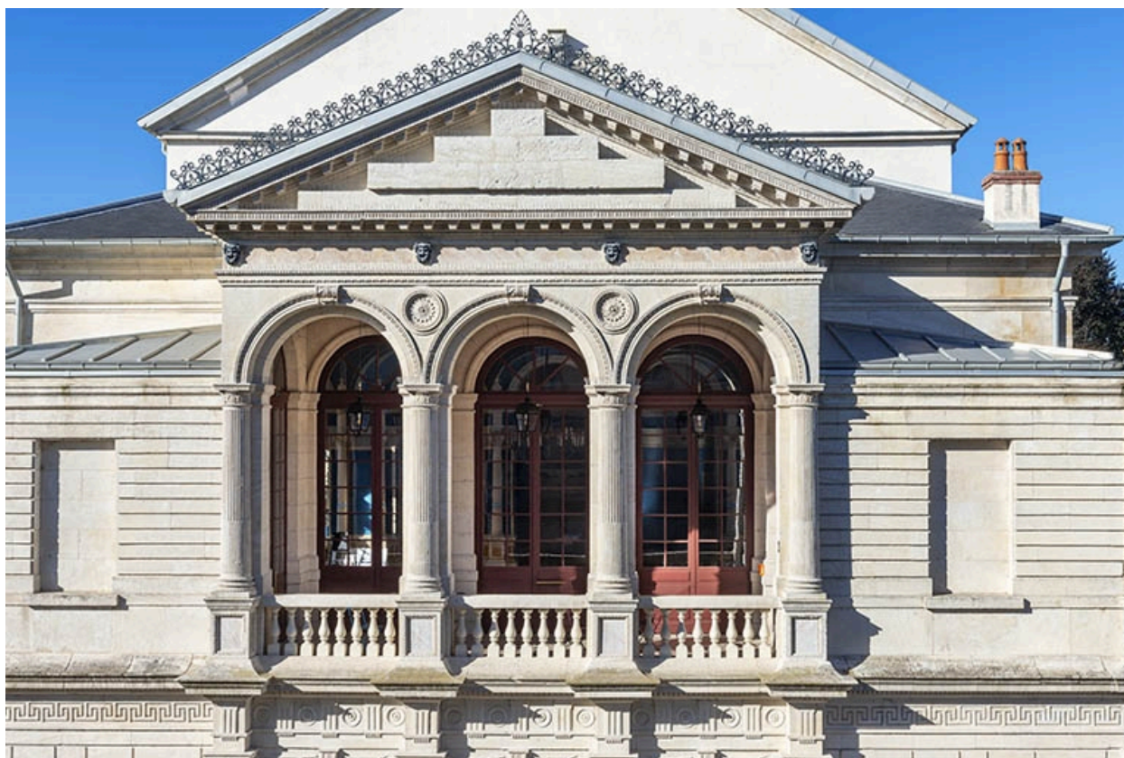
Façade antérieure : loggia.
