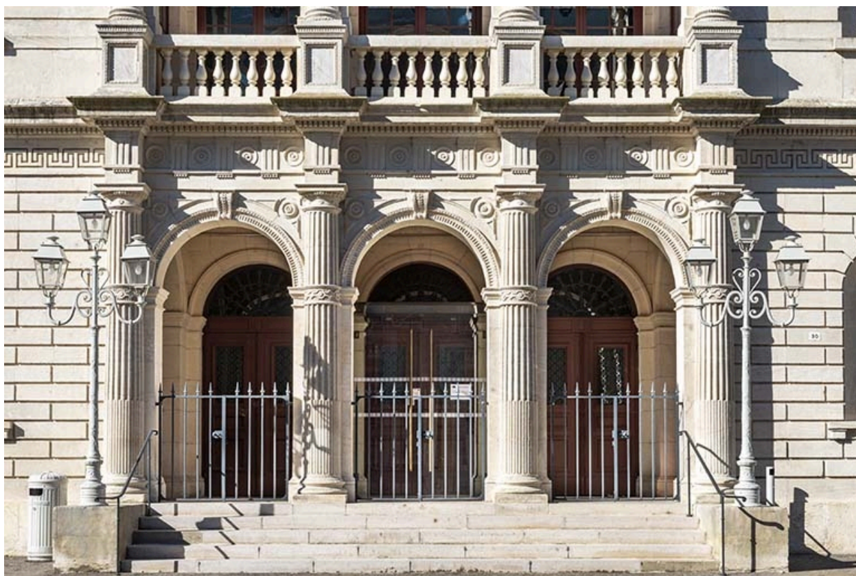
Façade antérieure : baies du rez-de-chaussée.
