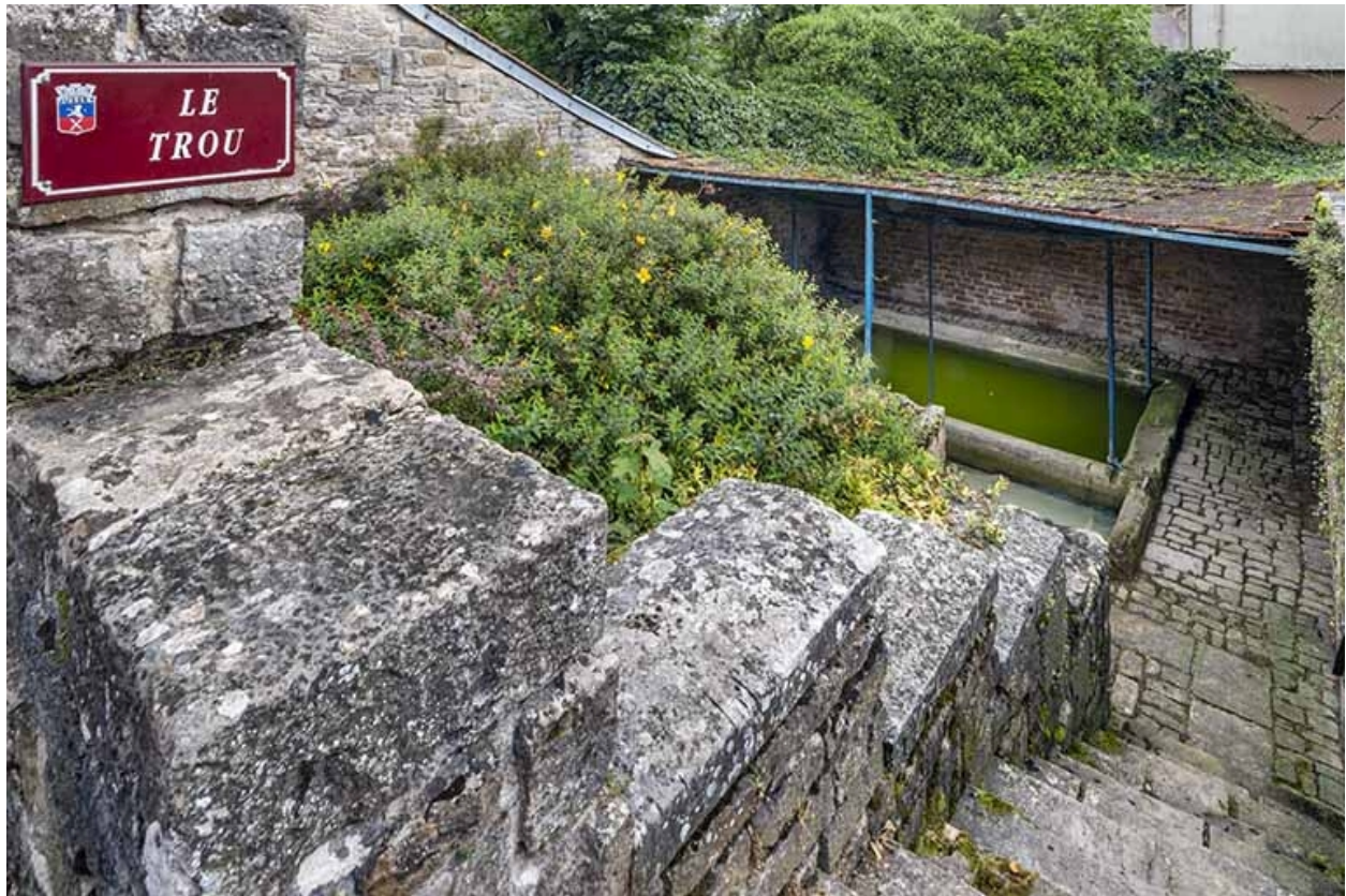
L'escalier et les bassins depuis la rue.
