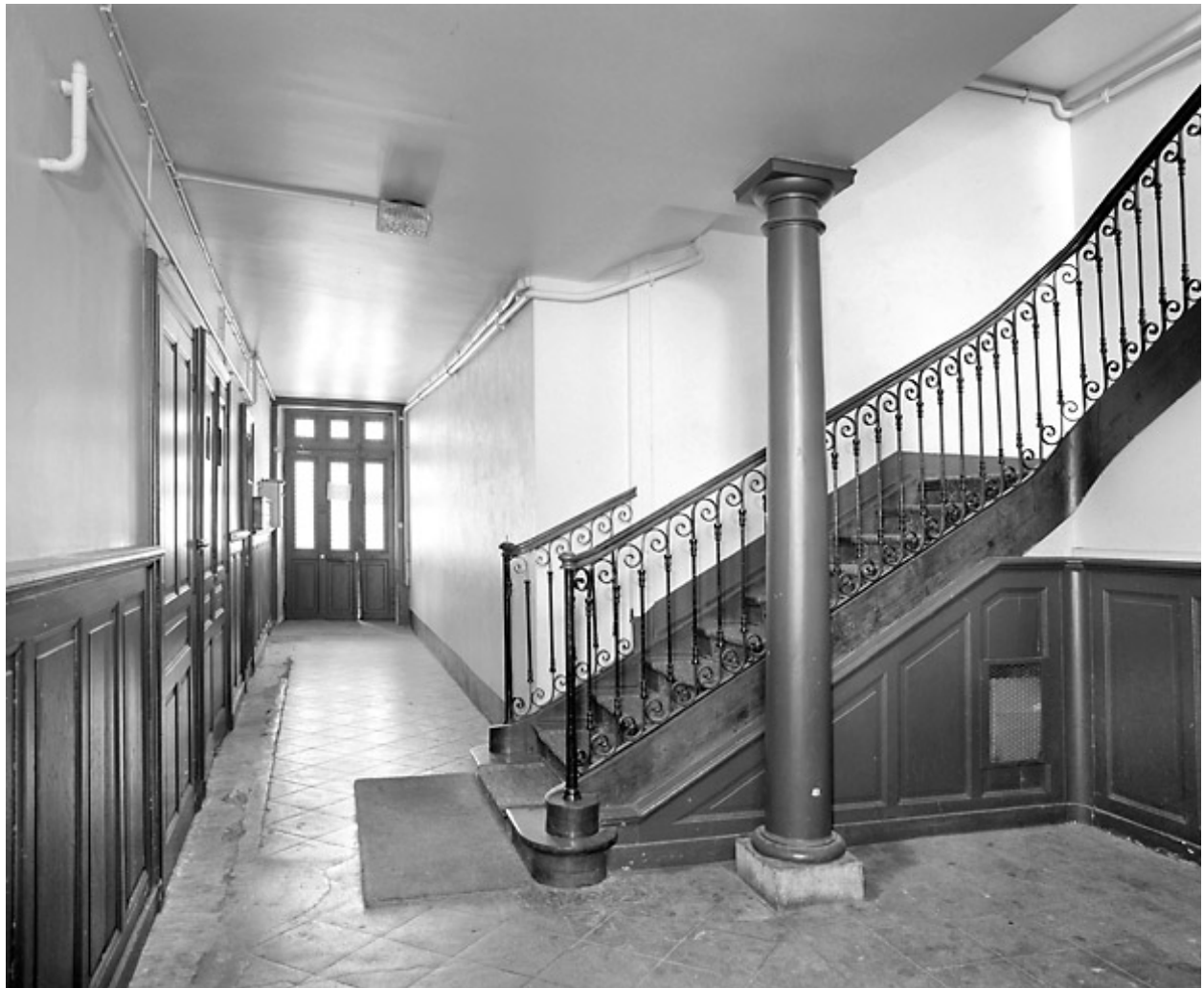
Couloir et escalier tournant.
