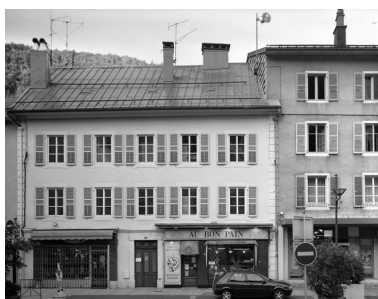
Vue d'ensemble rue de la République. Phot. Yves Sancey IVR43_20033900779V
