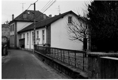
Vue d'ensemble des bâtiments. Phot. Bernard Lardière IVR43_19832500142Z
