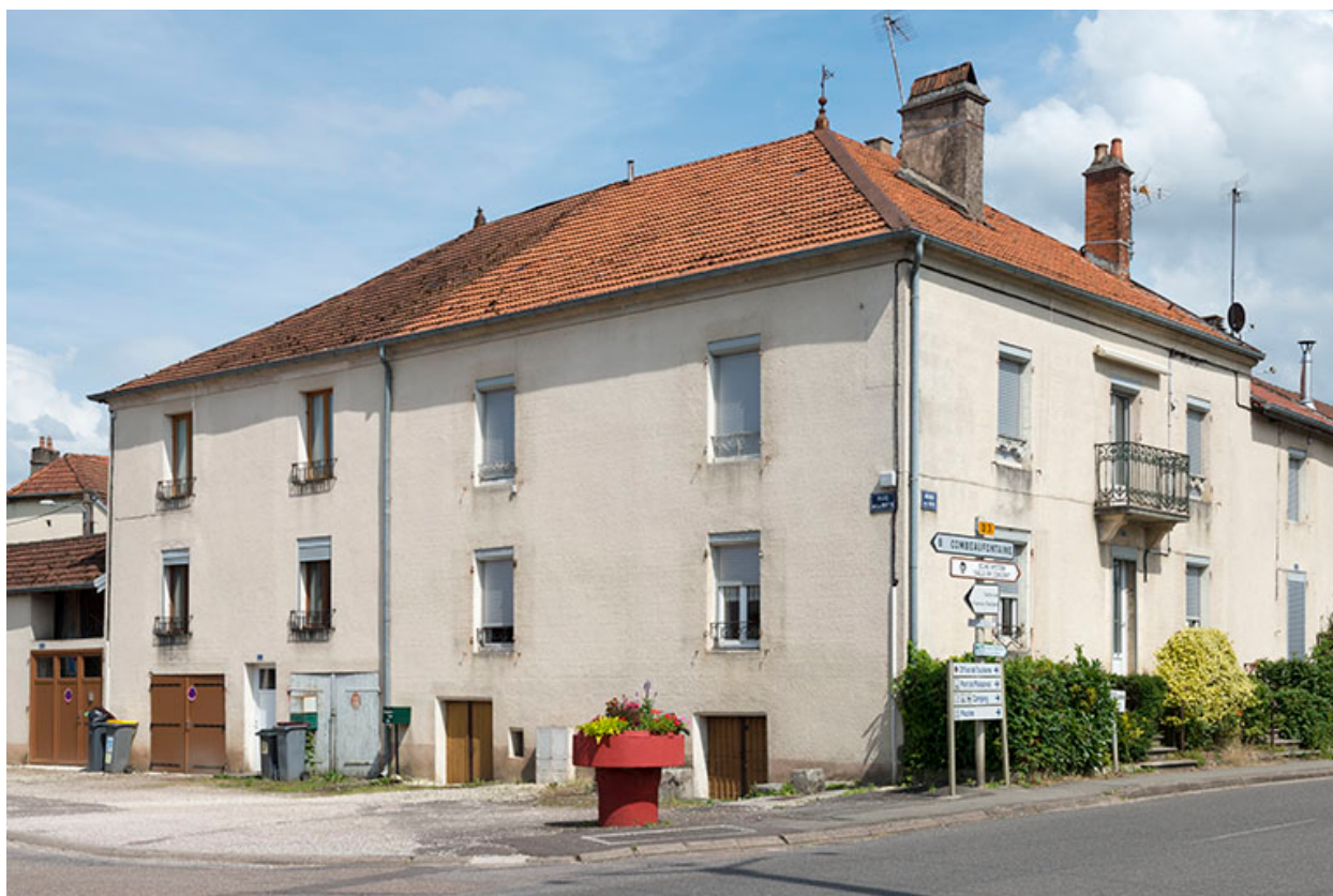
Élévation depuis la rue Hugot.
