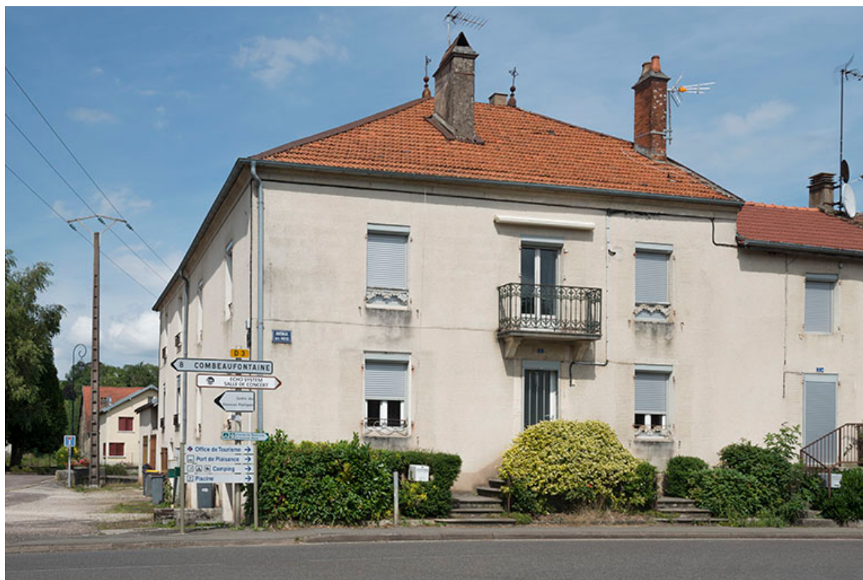
Élévation depuis l'avenue des Pâtis.
