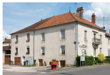
Élévation depuis la rue Hugot. Phot. Jérôme Mongreville IVR43_20187000387NUC4A
