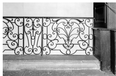
Partie droite. Phot. Yves Sancey IVR43_19752501157V
