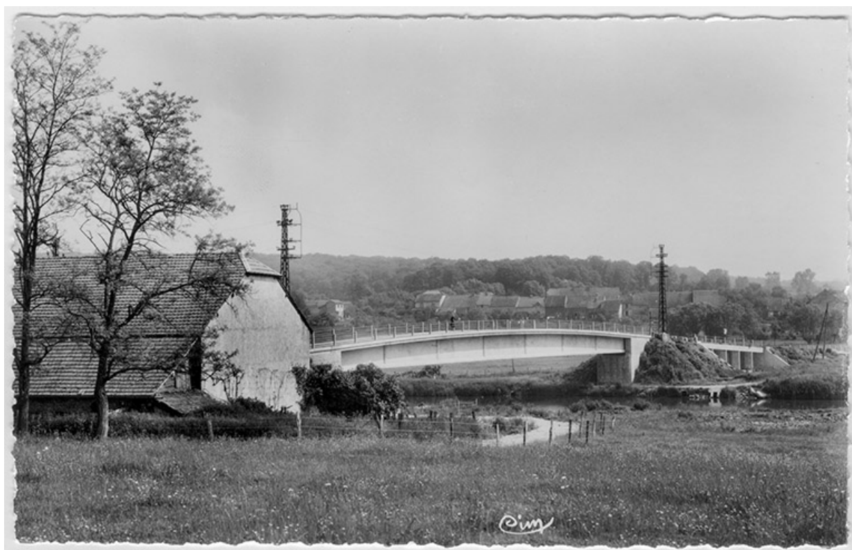
Pont en béton remplaçant le pont métallique
