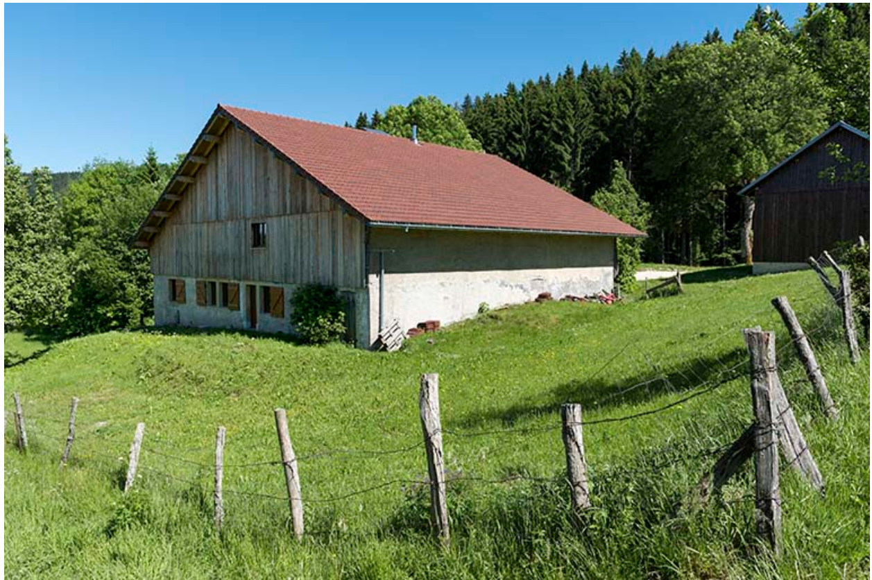
Façades postérieure et latérale gauche.
