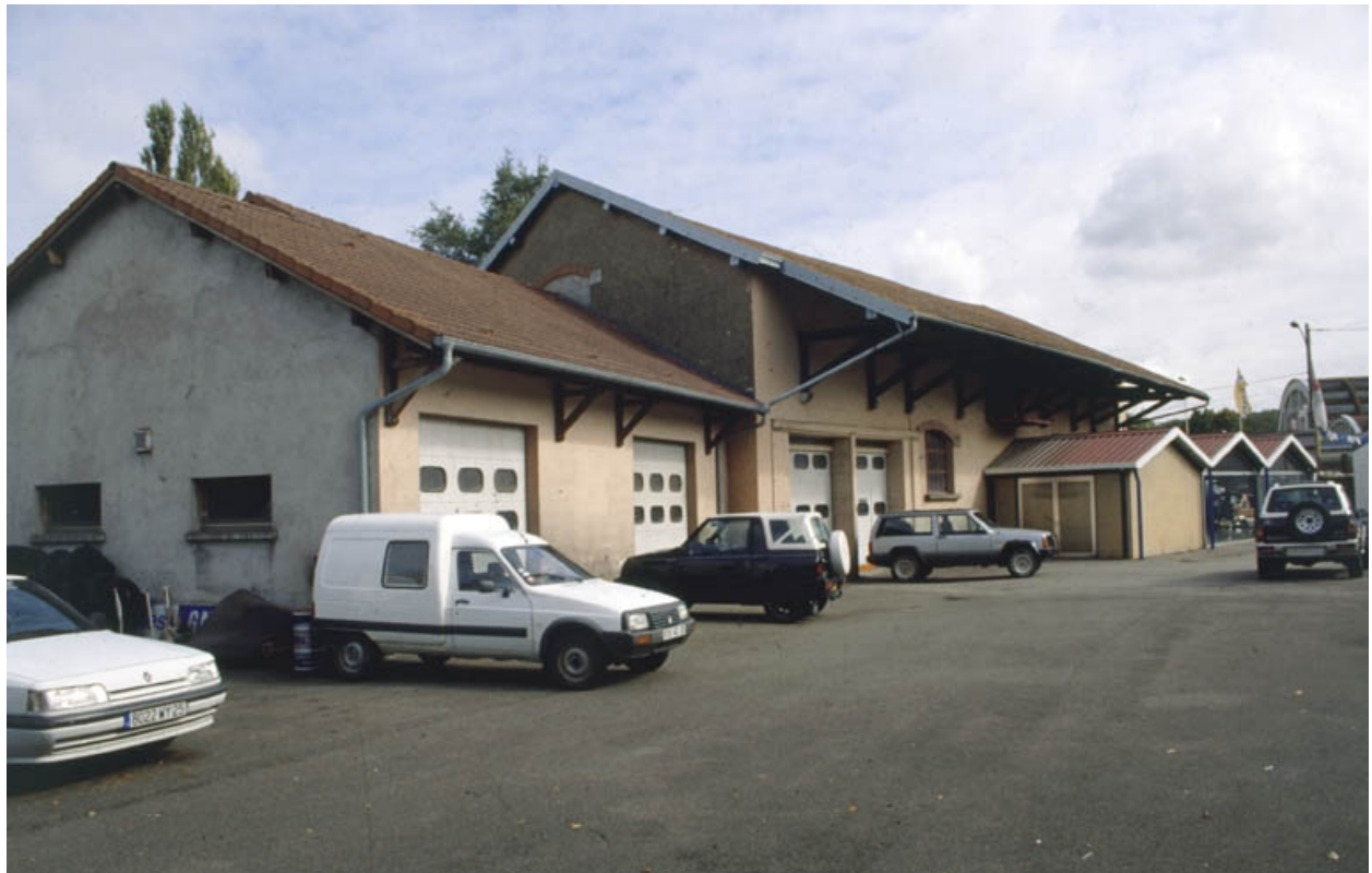
Magasin industriel depuis la cour.
