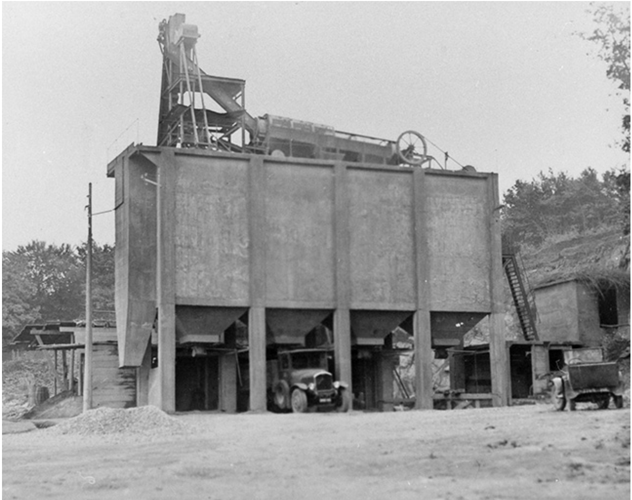
Poste de concassage (C) vu de l'ouest, 1931.
