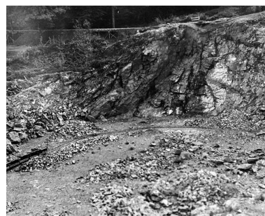
Le front de taille de la carrière, 1931. Phot. Yves Sancey IVR43_19893900019X
