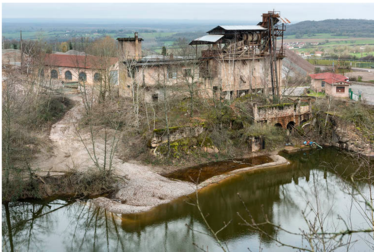
Vue plongeante sur l'ancien site.
