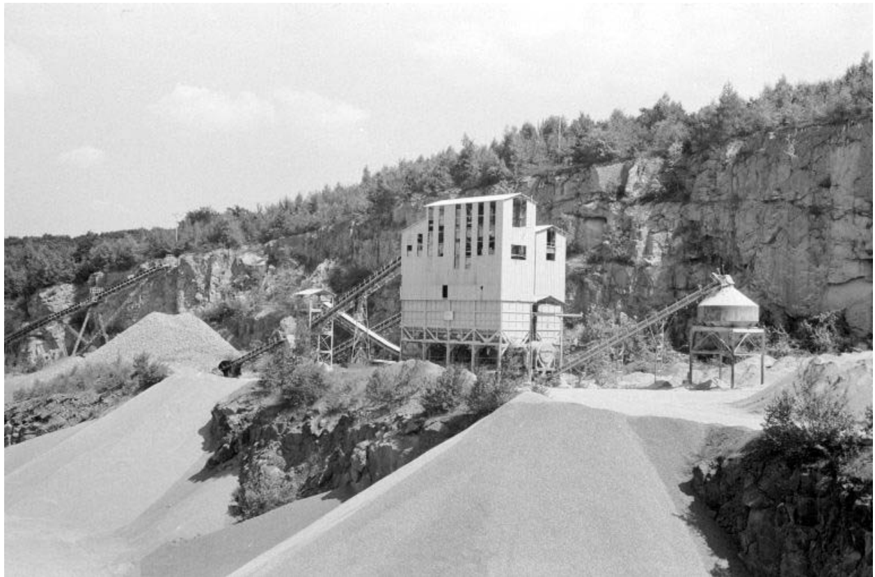
Site d'extraction et nouvelles installations de concassage, en 1988.
