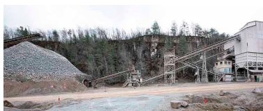
Nouvelles installations : tapis roulants et poste de concassage. Phot. Sonia Dourlot IVR43_20203900015NUC4A
