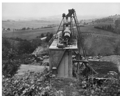
Installation de triage après concassage, 1931. Phot. Yves Sancey IVR43_19893900017X
