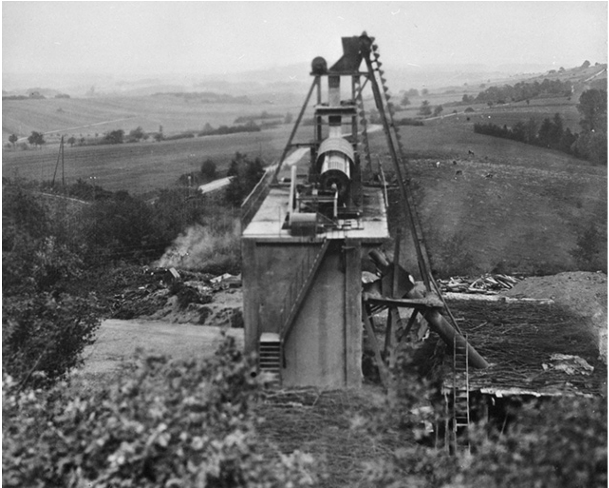
Installation de triage après concassage, 1931.
