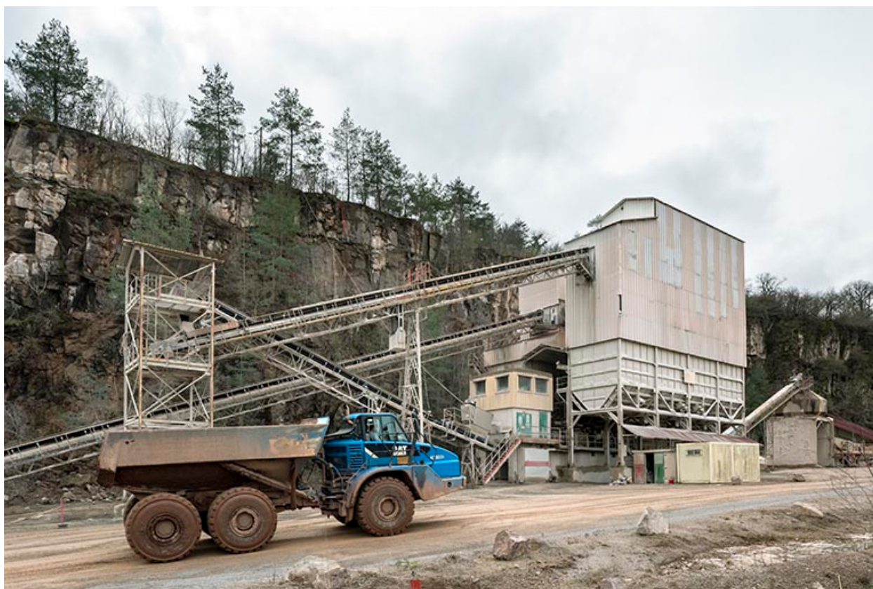
Nouvelles installations : poste de concassage, avec camion.
