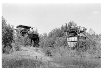
Anciennes installations, en 1988 : trémie et poste de concassage (I). Phot. Laurent Poupard IVR43_19883900126Z
