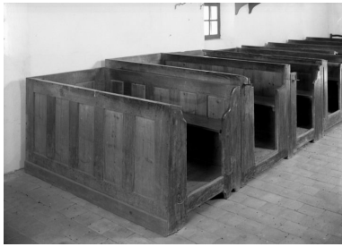
Vue générale. Phot. Michel Thierry IVR26_19862101170V
