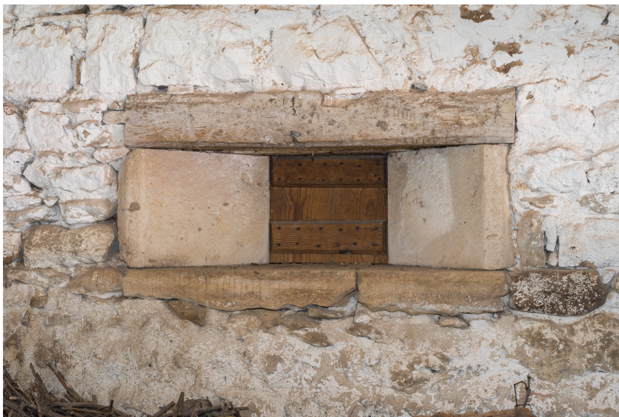
Vue rapprochée d'une baie -dite feuron- ménagée dans la cloison entre la grange et l'étable.
