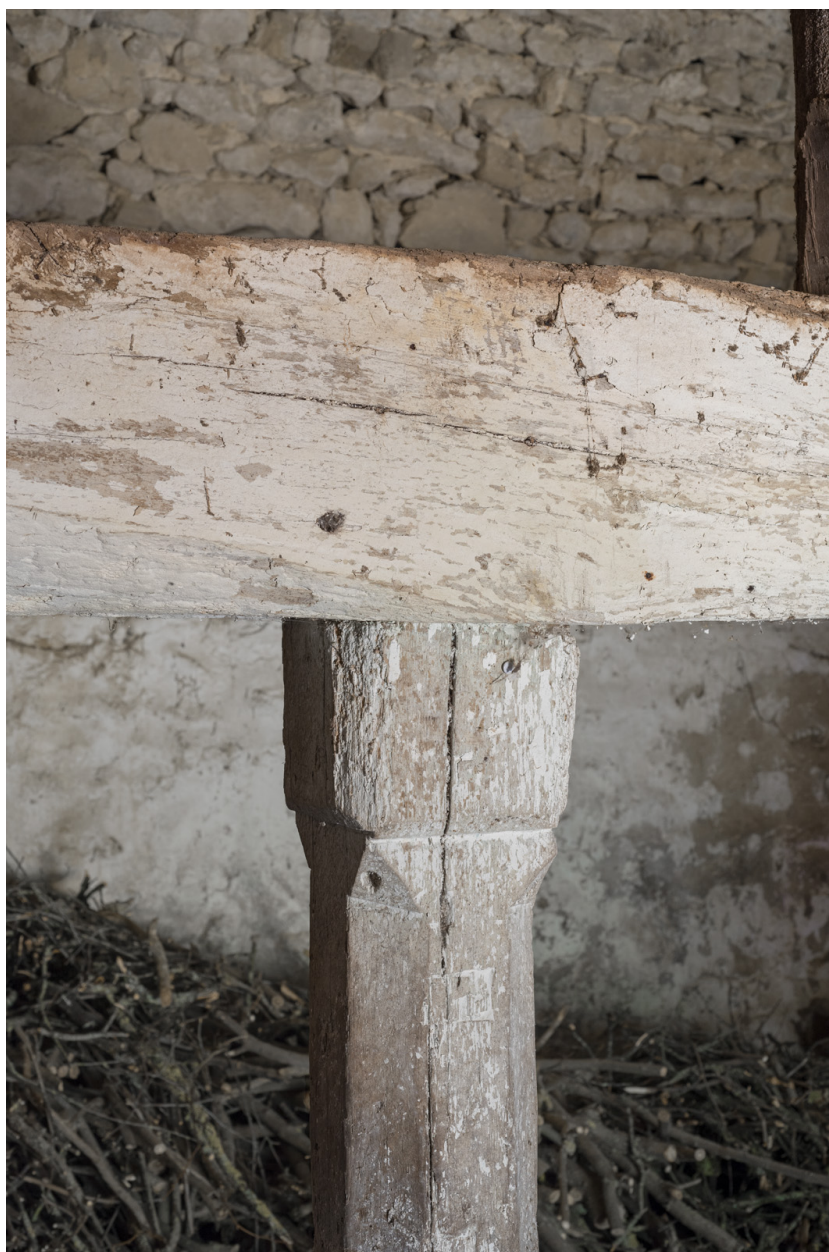
Vue rapprochée d'un assemblage poutre-poteau.
