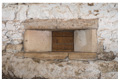
Vue rapprochée d'une baie - dite feuron- menagée dans la cloison entre la grange et l'étable. Phot. Pierre-Marie Barbe-Richaud IVR26_20187100375NUC4A
