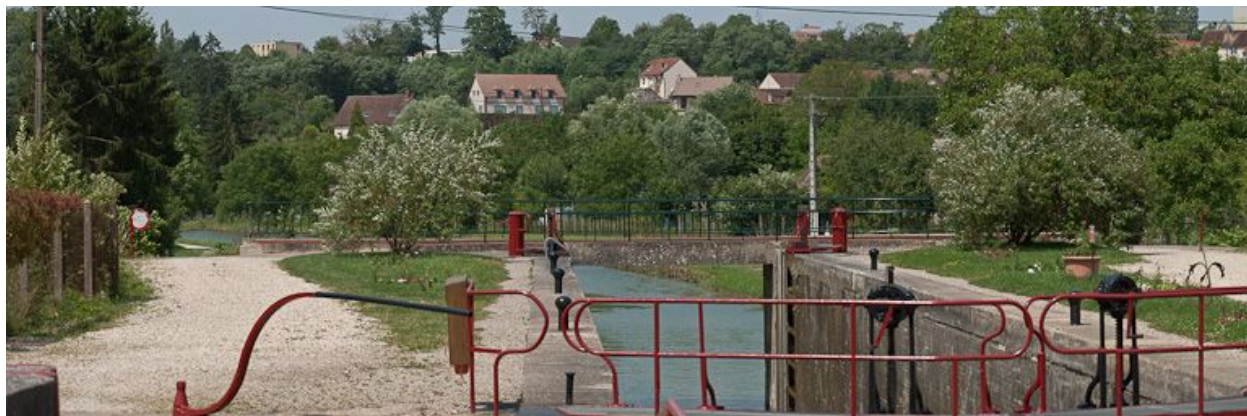
Vue du pont depuis l'amont.
