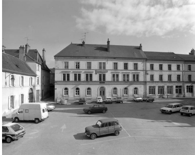
Façade antérieure de face : vue éloignée. Phot. Yves Sancey IVR43_19897000288X
