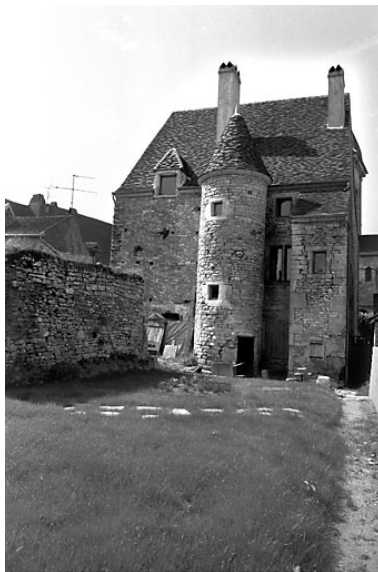
Façade postérieure. Phot. Bernard Lardière IVR43_19817000741Z
