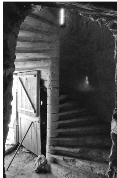
Détail : escalier en vis. Phot. Bernard Lardière IVR43_19817000742Z
