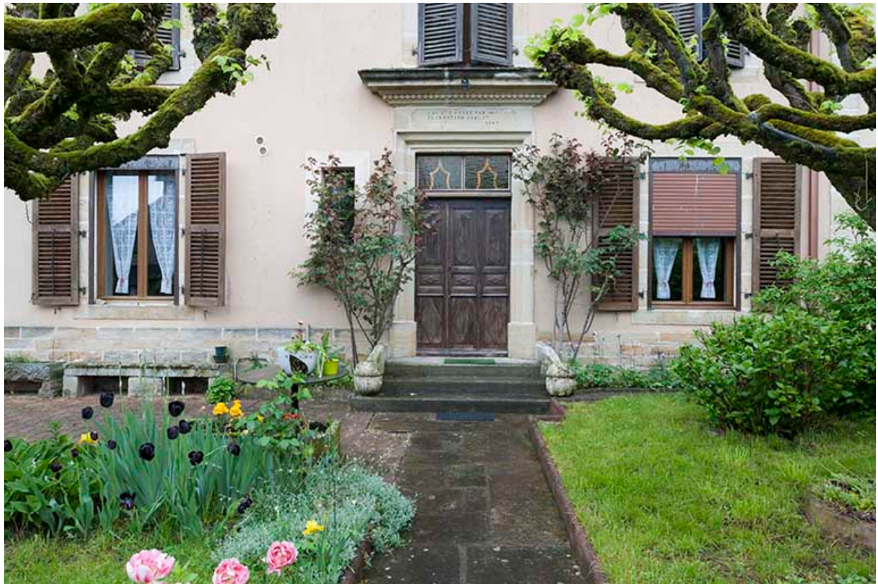
Le rez-de-chaussée, façade principale.
