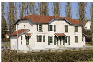
Habitation à 4 logements vue depuis le sud-ouest. Phot. Marc Loukachine IVR43_20122500250NUC2A
