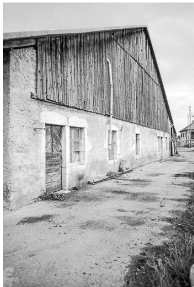
Ferme cadastrée 1962 E 11 : façade antérieure. Phot. Gilbert Poinot IVR43_19752501503Z
