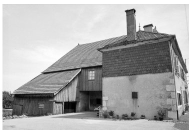
Ferme cadastrée 1962 E 80 : façade postérieure. Phot. Gilbert Poinot IVR43_19752501506Z
