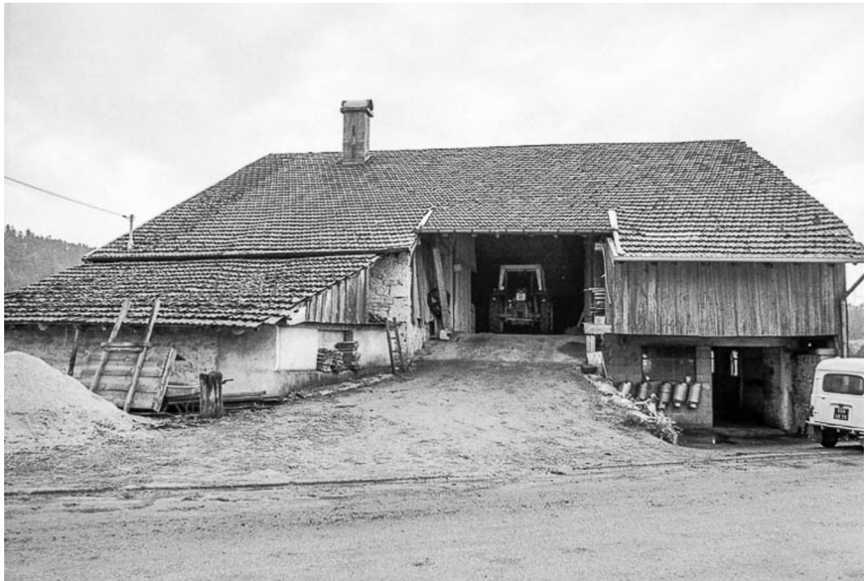
Ferme cadastrée 1962 E 11 : façade sur rue.
