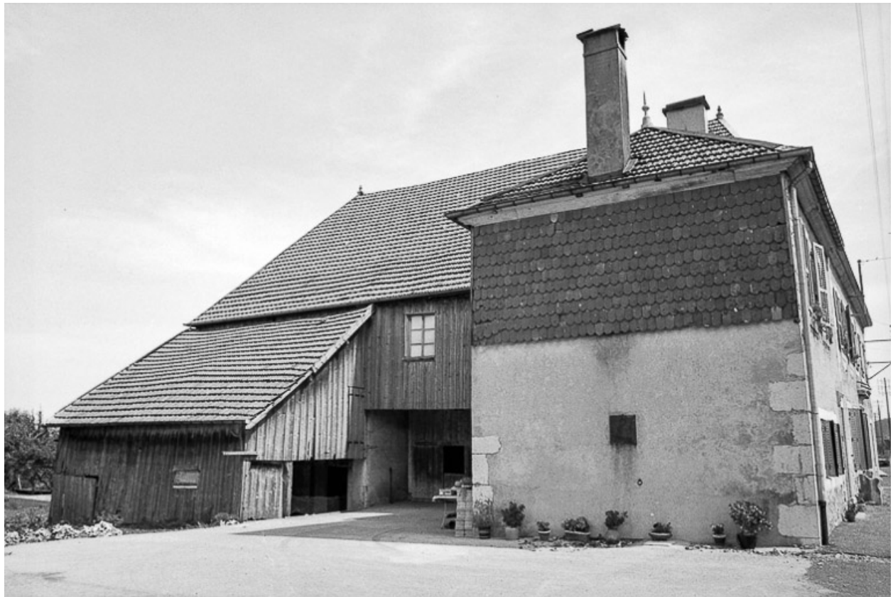
Ferme cadastrée 1962 E 80 : façade postérieure.
