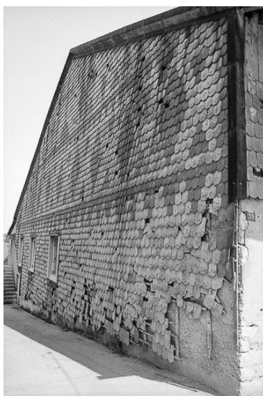
Ferme cadastrée 1962 E 106, 346-347 : façade avec tavaillons. Phot. Gilbert Poinot IVR43_19752501512Z
