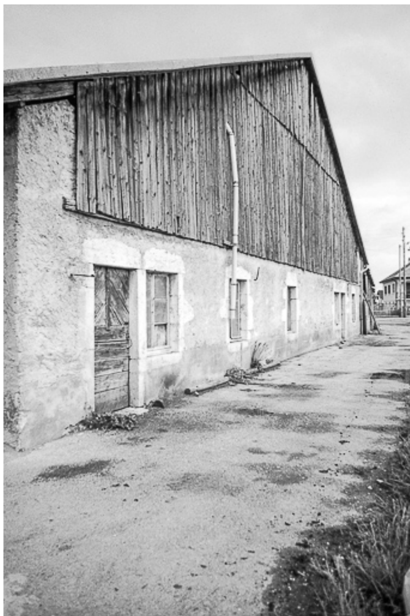
Ferme cadastrée 1962 E 11 : façade antérieure.
