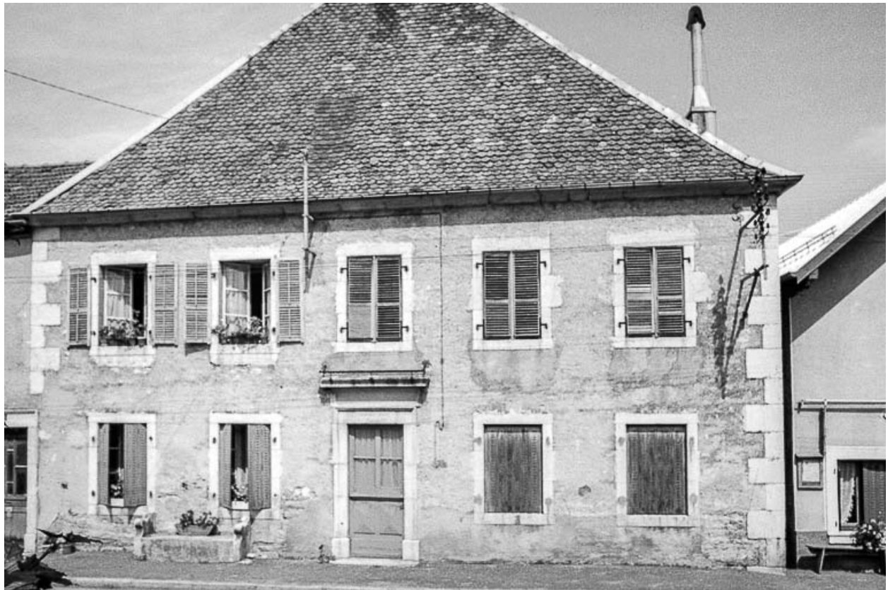
Ferme cadastrée 1962 E 80 : façade antérieure.
