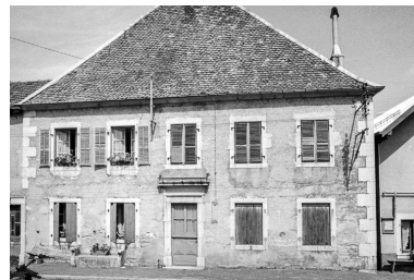
Ferme cadastrée 1962 E 80 : façade antérieure. Phot. Gilbert Poinot IVR43_19752501505Z
