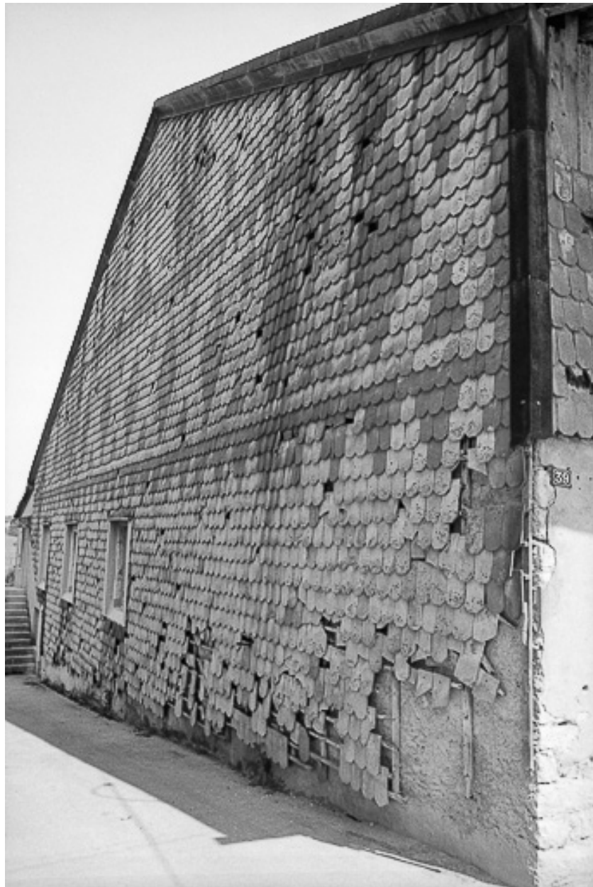
Ferme cadastrée 1962 E 106, 346-347 : façade avec tavaillons.
