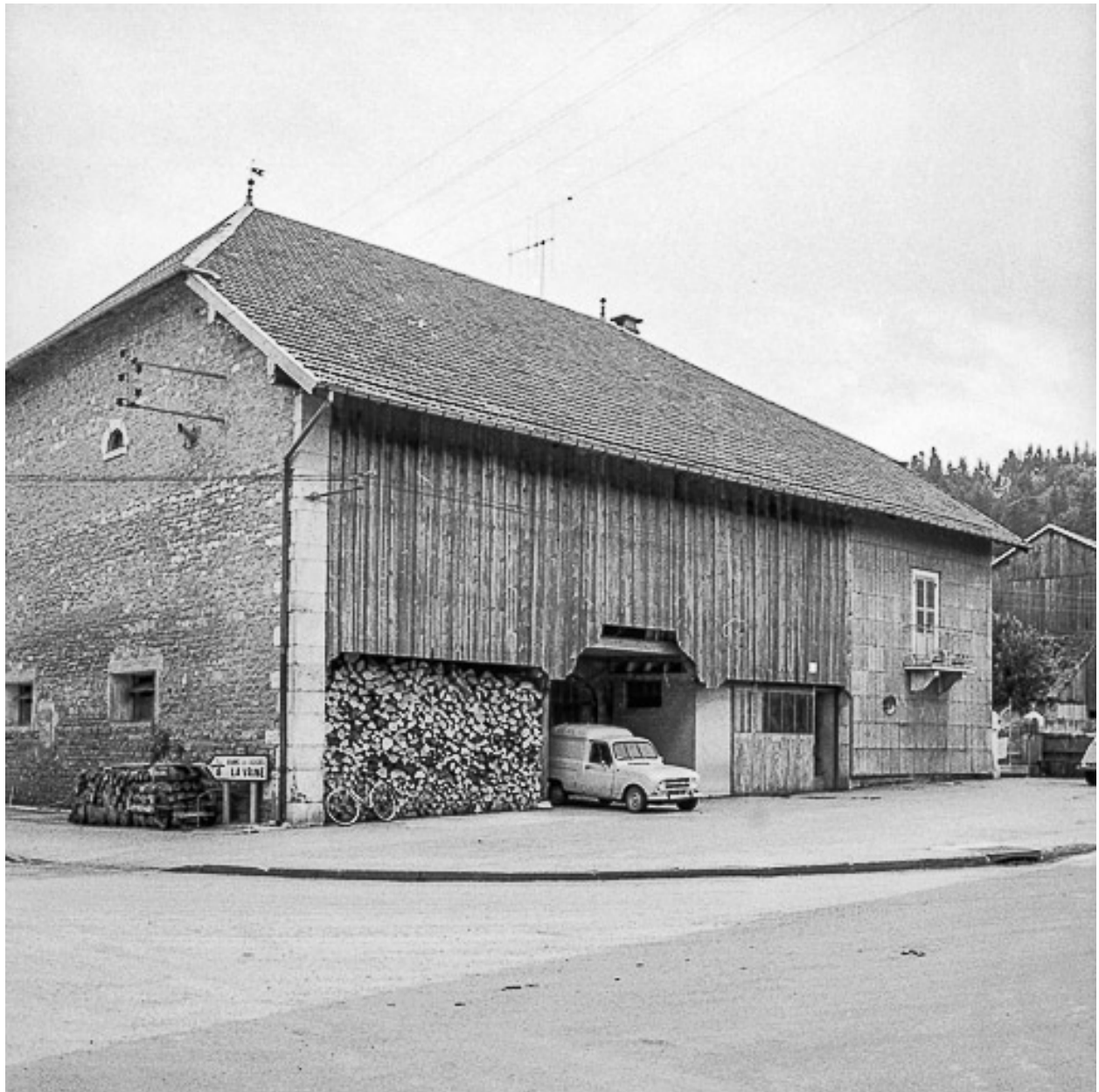
Ferme cadastrée 1962 E 281 bis : façade latérale gauche.
