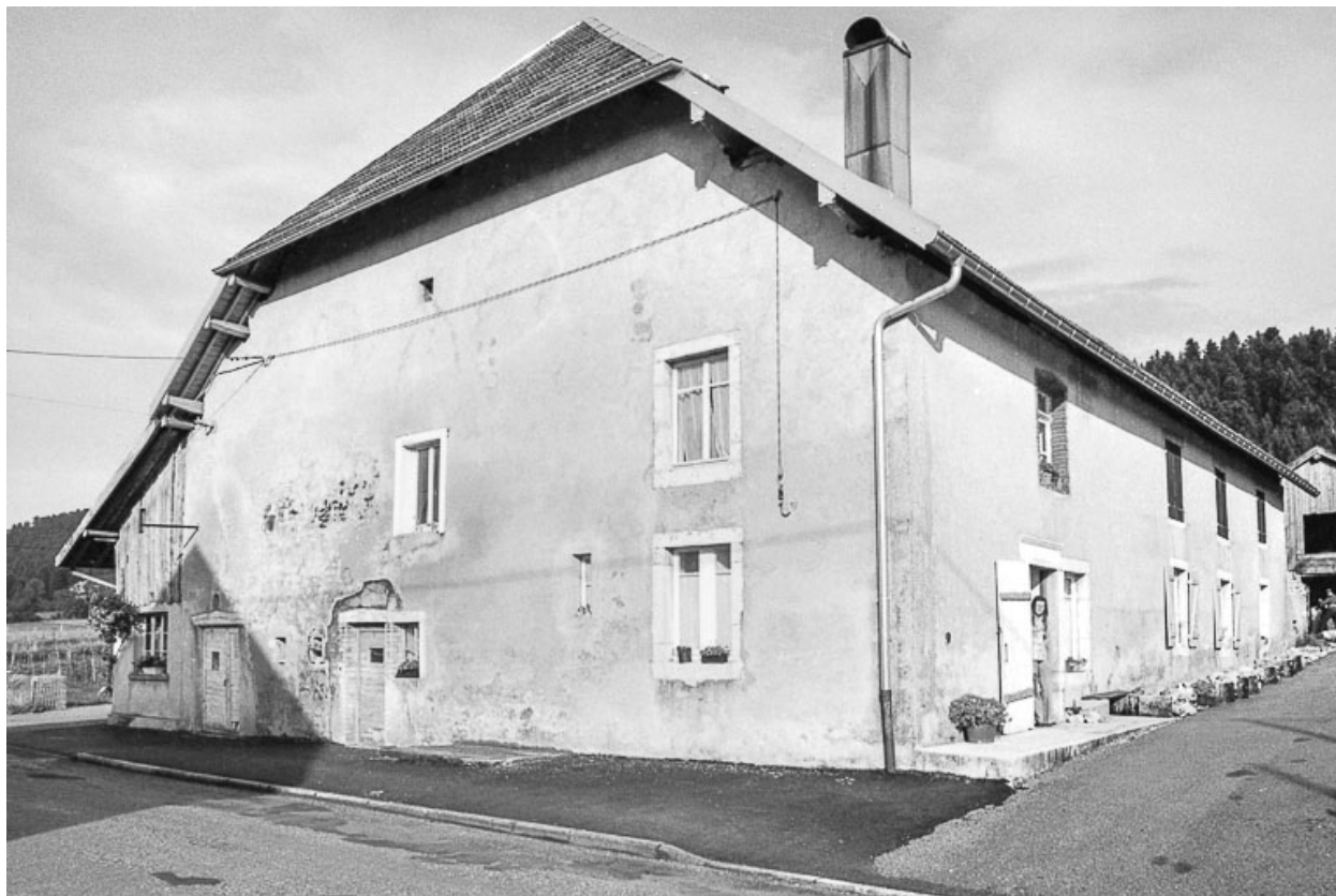
Ferme cadastrée 1962 E 109 : façade sur rue.
