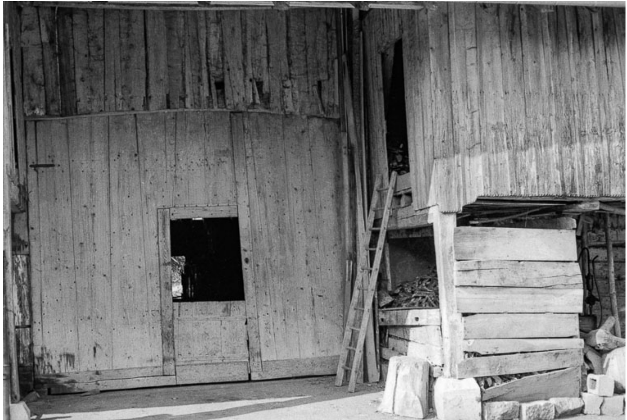
Ferme cadastrée 1962 E 174-175 : porte de grange et galerie en bois fermée servant de bûcher.
