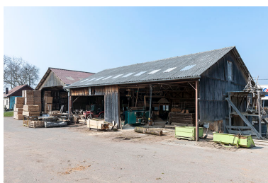
Atelier de sciage depuis le sud-est. Phot. Jérôme Mongreville IVR43_20152500422NUC4A
