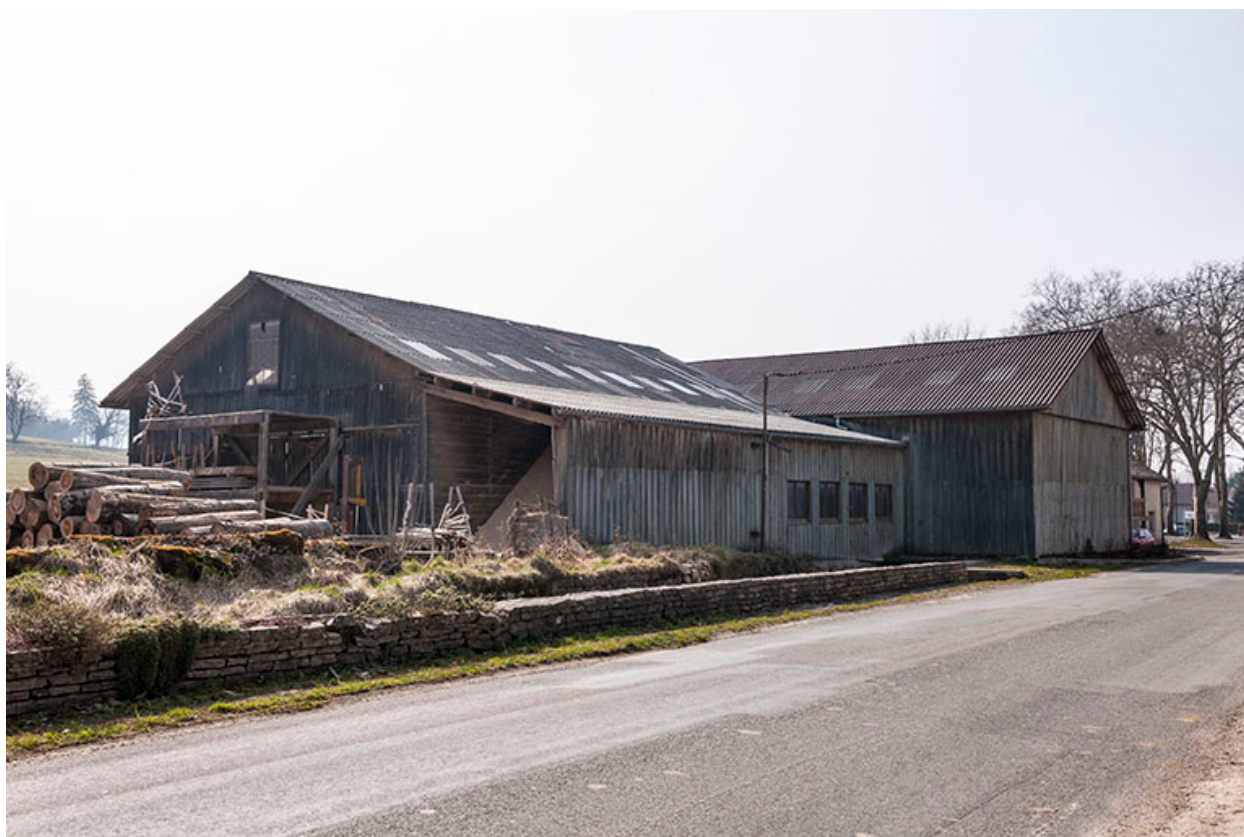
Atelier de sciage depuis le nord-est.
