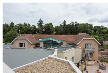
Vue actuelle, côté parc. Phot. Pierre-Marie Barbe-Richaud IVR26_20217100253NUC4A
