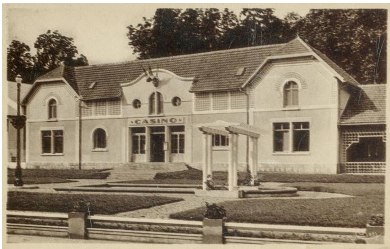
Façade sur la rue.
