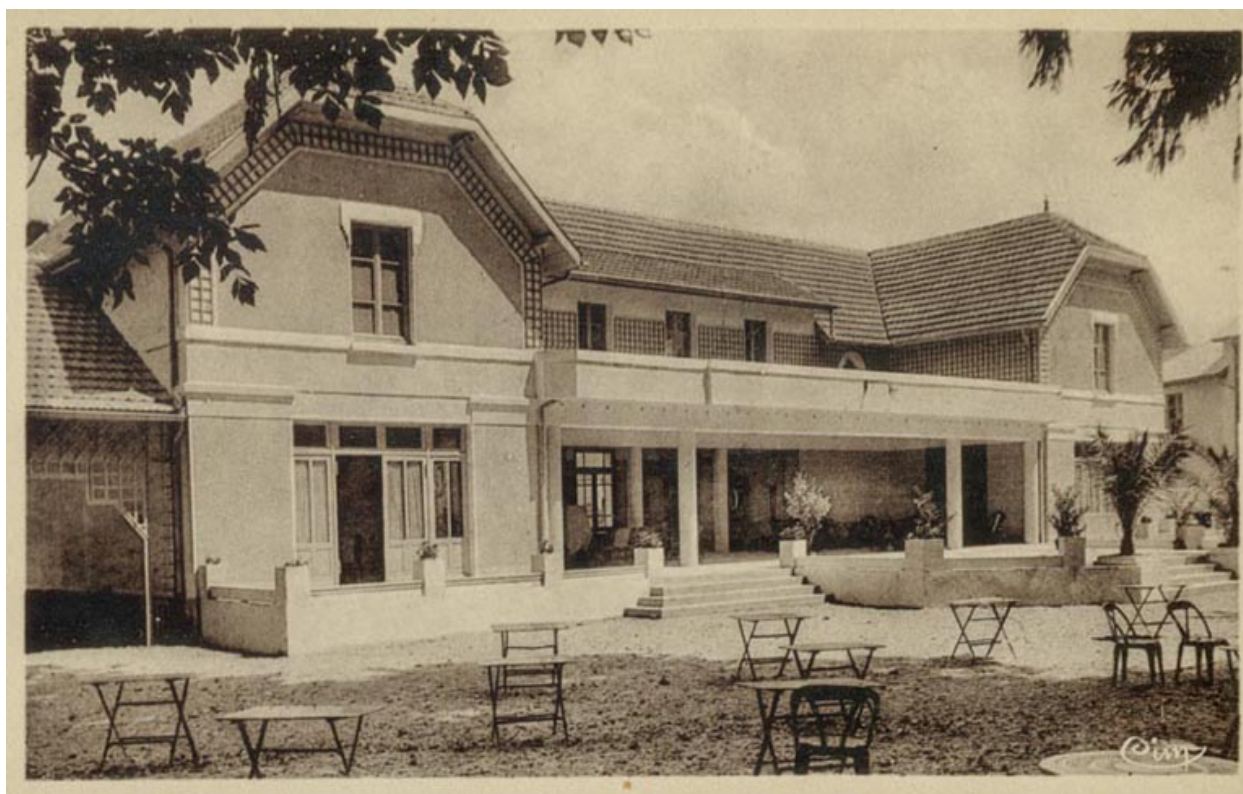
Façade sur le parc.
