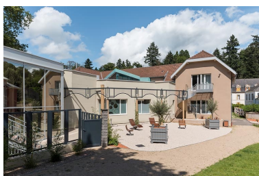
Vue actuelle, côté parc. Phot. Pierre-Marie Barbe-Richaud IVR26_20217100251NUC4A
