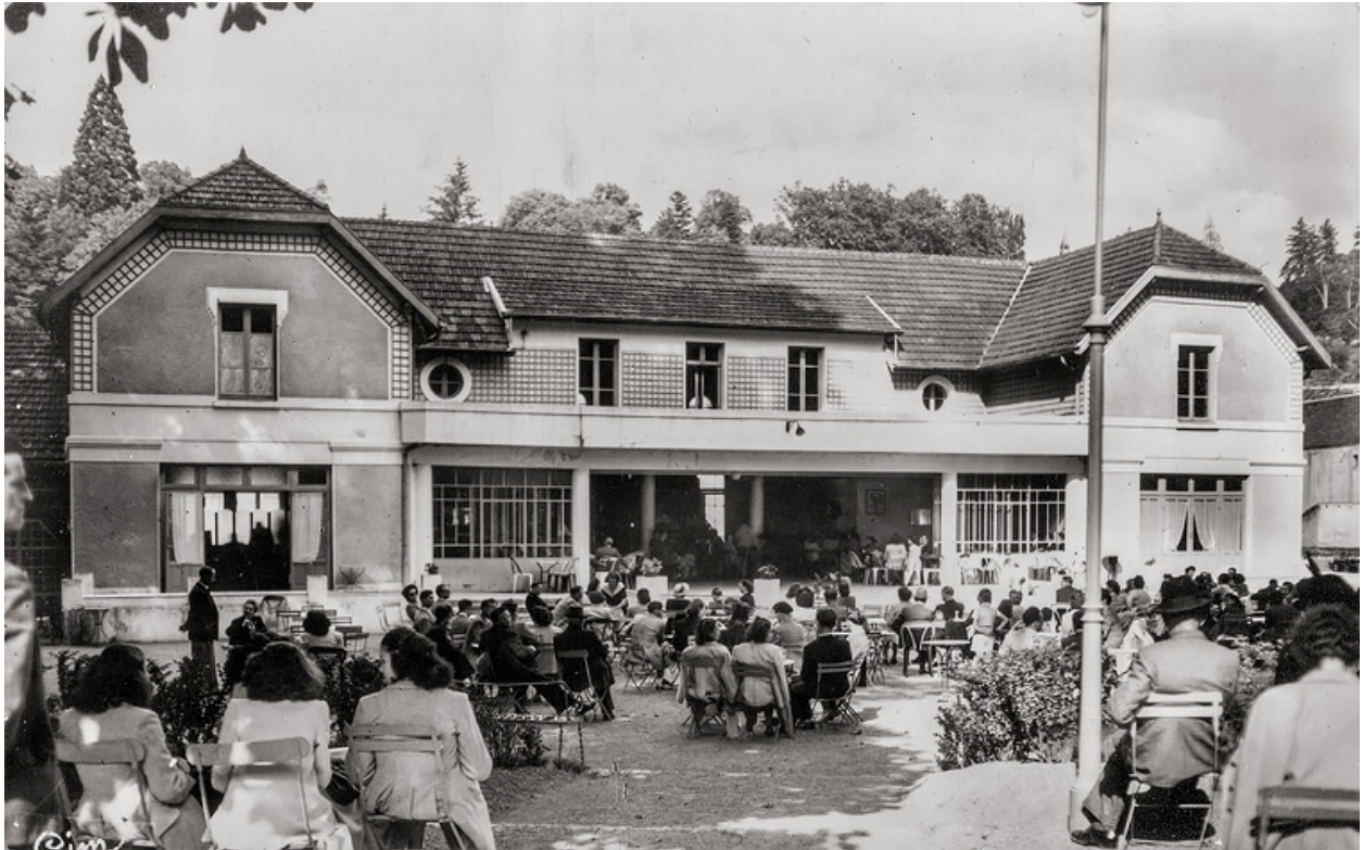
Façade sur le parc.
