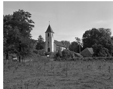
Vue de situation. Phot. Yves Sancey IVR43_19843900113X
