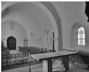
Intérieur : élévation gauche. Phot. Yves Sancey IVR43_19843900118X
