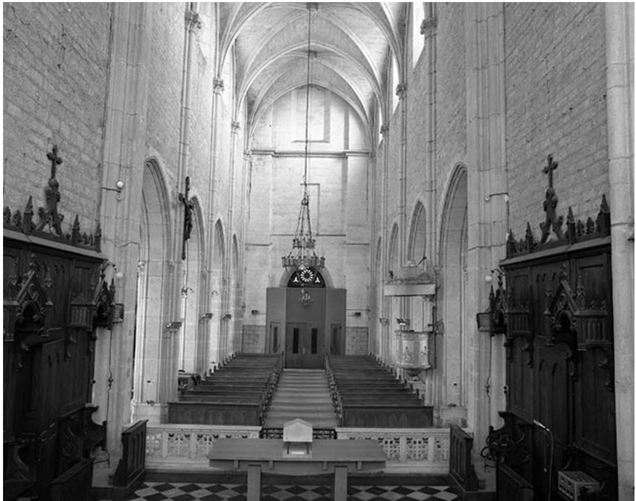
Nef vue depuis le chœur.
