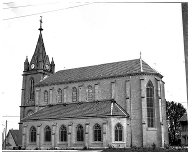
Façade latérale sud. Phot. Yves Sancey IVR43_19752500382X
