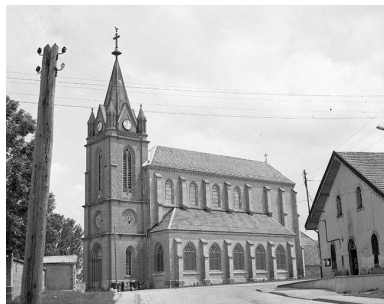
Tour-clocher et façade latérale sud. Phot. Yves Sancey IVR43_19752500380X
