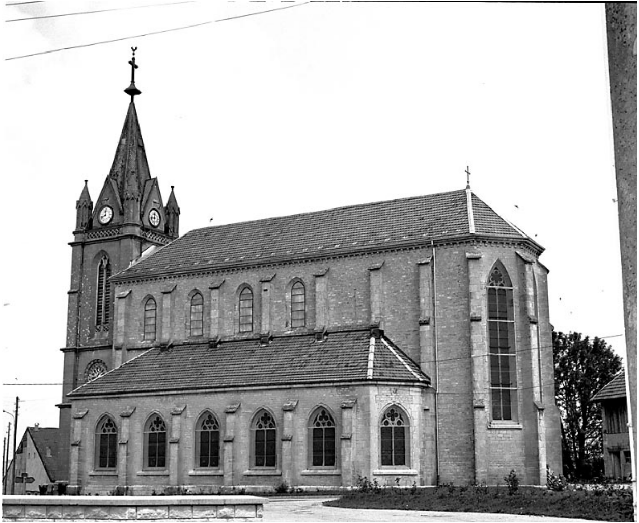
Façade latérale sud.
