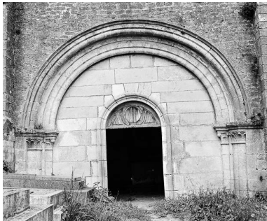
Portail d'entrée. Phot. Yves Sancey IVR43_19777000107X
