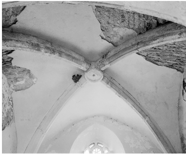
Intérieur : voûte de la chapelle latérale droite. Phot. Yves Sancey IVR43_19777000112X
