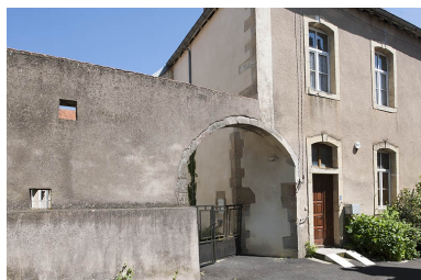
Façade latérale gauche. Phot. Jérôme Mongreville IVR43_20127000040NUC4A
