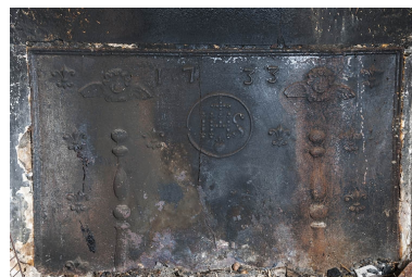
Cuisine : la plaque de cheminée. Phot. Jérôme Mongreville IVR43_201270000503NUC4A
