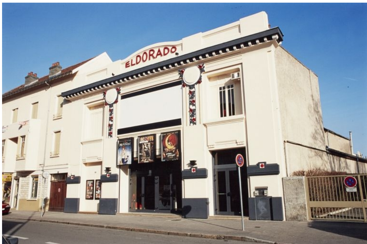
Elévation sur rue en 2000.
