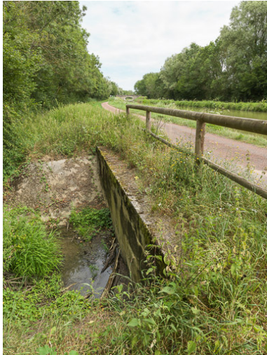
Vue de l'aqueduc. Phot. Pierre-Marie Barbe-Richaud IVR26_20175800192NUC2A
