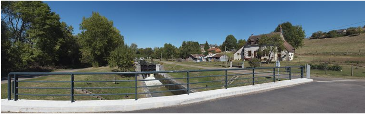
Vue d'ensemble du site d'écluse double.
