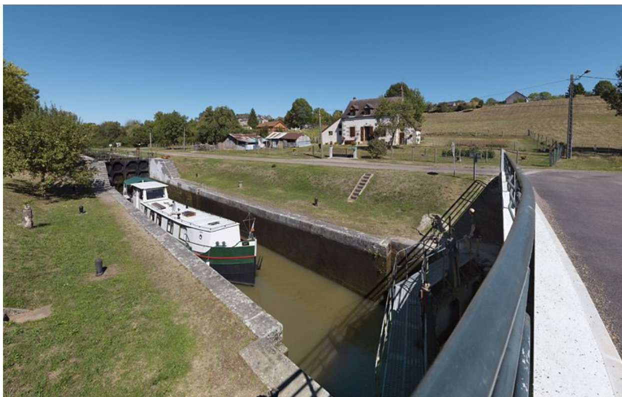
Le site d'écluse avec passage d'un bateau.
