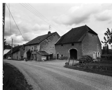
Ferme située rue de la Belgique. Phot. Yves Sancey IVR43_19813900069X
