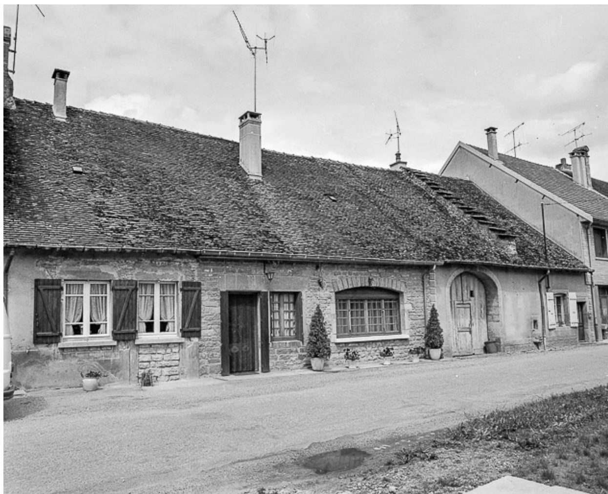
Maison et ferme situées rue de Bréry. A noter le toit à redents.
