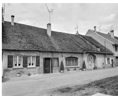
Maison et ferme situées rue de Bréry. A noter le toit à redents. Phot. Yves Sancey IVR43_19813900070X
