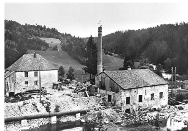
La centrale hydroélectrique de Bellefontaine. Phot. Jérôme Mongreville IVR43_19973900938X
