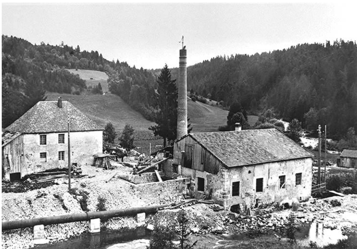
La centrale hydroélectrique de Bellefontaine.
