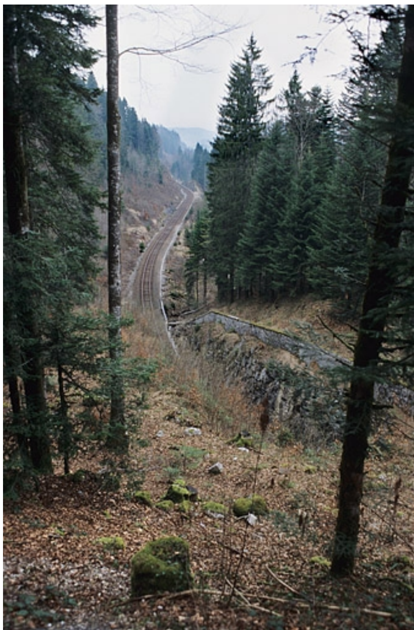
Tranchée et mur de protection côté Andelot-en-Montagne.
