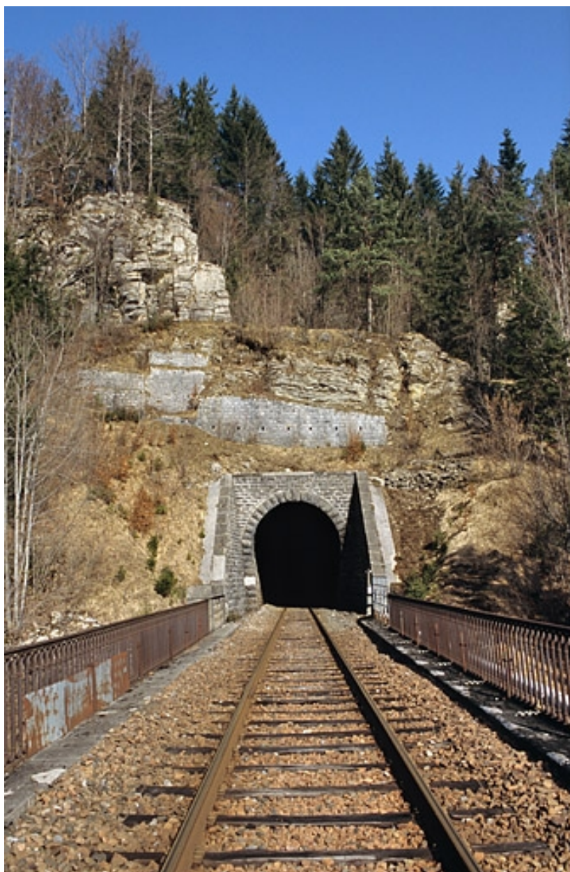
Tunnel : tête du côté La Cluse.
