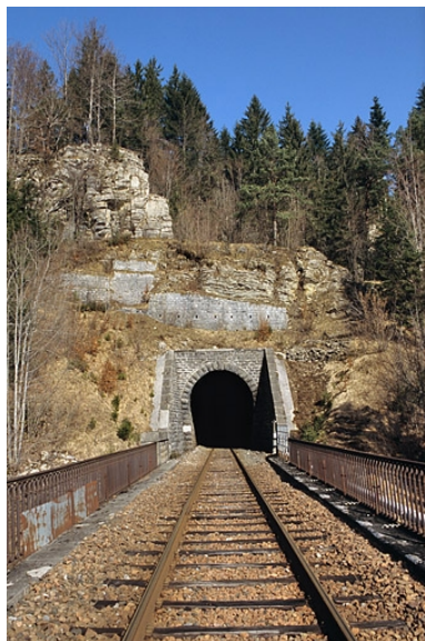
Tunnel : tête du côté La Cluse.
