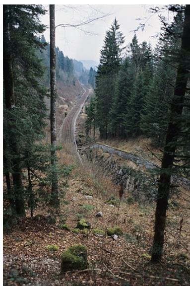
Tranchée et mur de protection côté Andelot-en-Montagne. Phot. Yves Sancey IVR43_20053900132ZA
