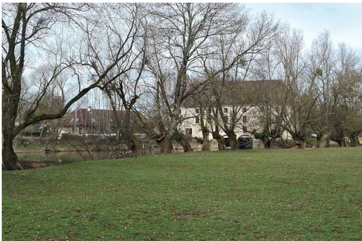
Moulin de Bourgchâteau, vu d'aval.
