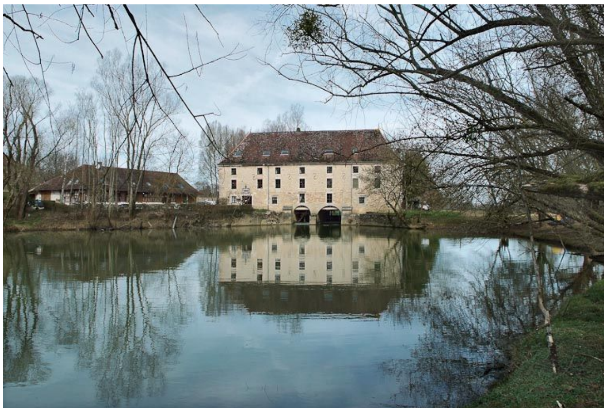
Moulin de Bourgchâteau, vu d'aval.
