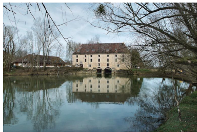
Moulin de Bourgchâteau, vu d'aval.
