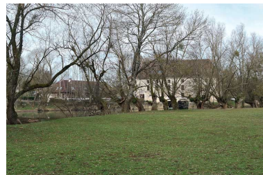
Moulin de Bourgchâteau, vu d'aval.
