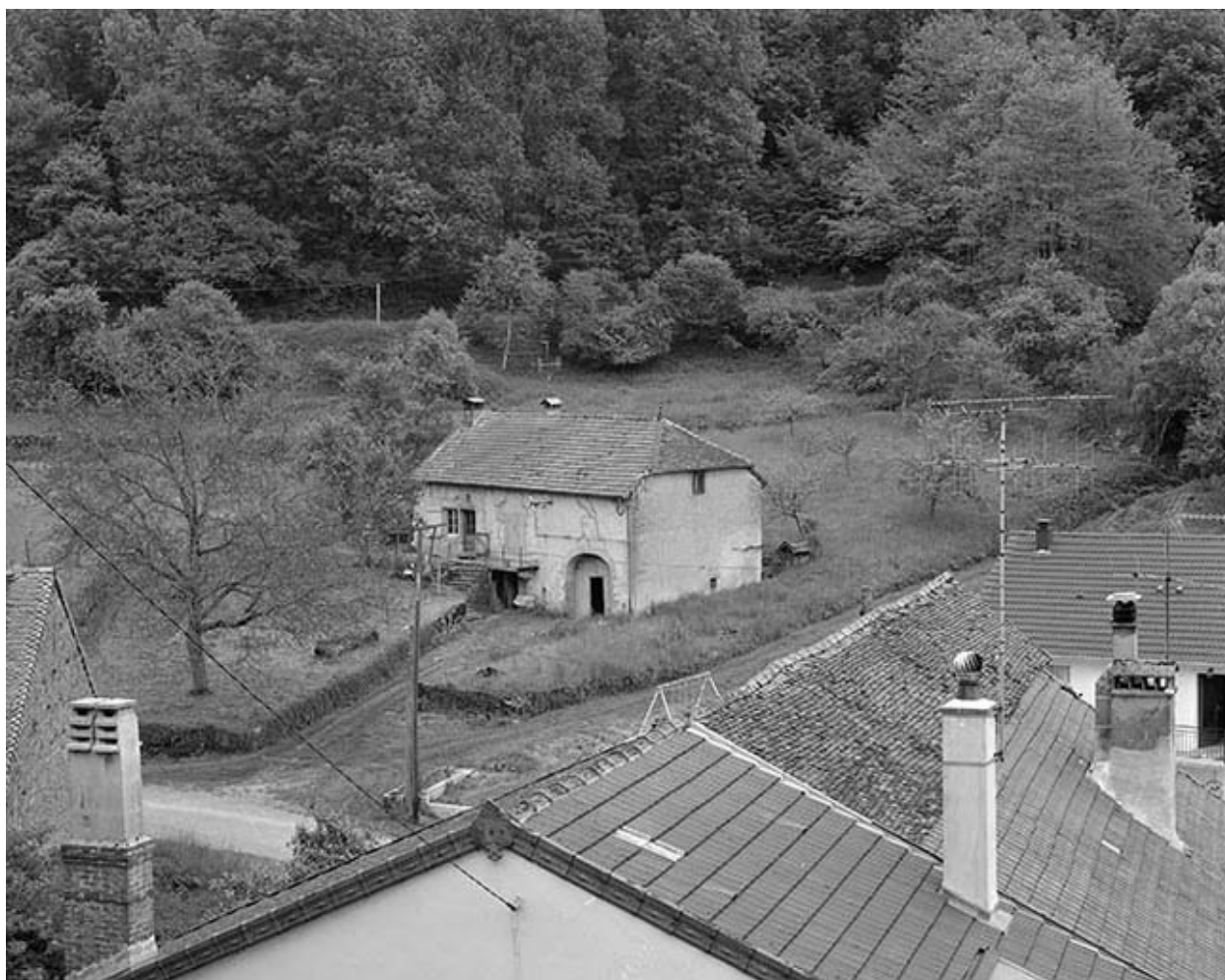
Ferme située rue Saint-Vincent : vue d'ensemble.
