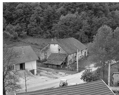
Ferme située rue Saint- Vincent : vue d'ensemble.
