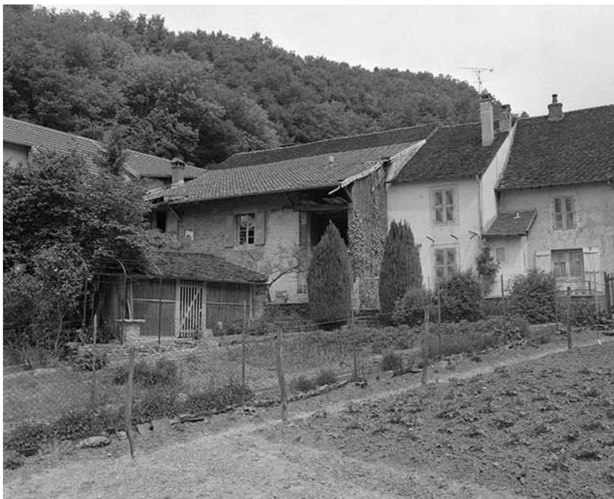
Ferme située rue du Fond de Vau : façade postérieure.
