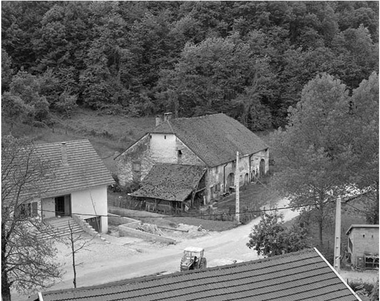
Ferme située rue Saint-Vincent : vue d'ensemble.
