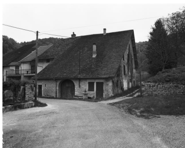
Ferme située rue du Fond de Vau : façade antérieure. Phot. Yves Sancey IVR43_19813900110X
