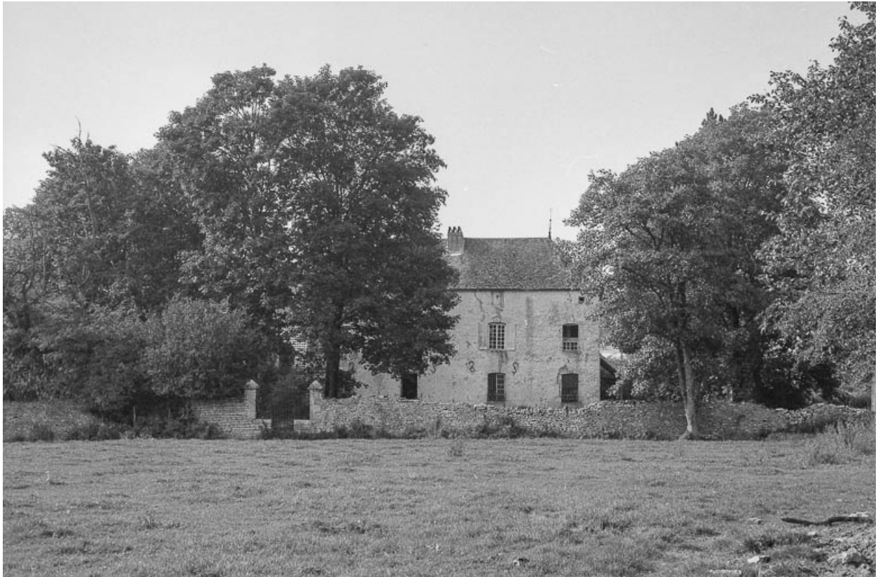
Façade sur le parc.
