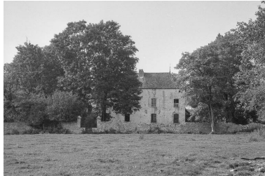
Façade sur le parc. Phot. Bernard Lardière IVR43_19797000163Z
