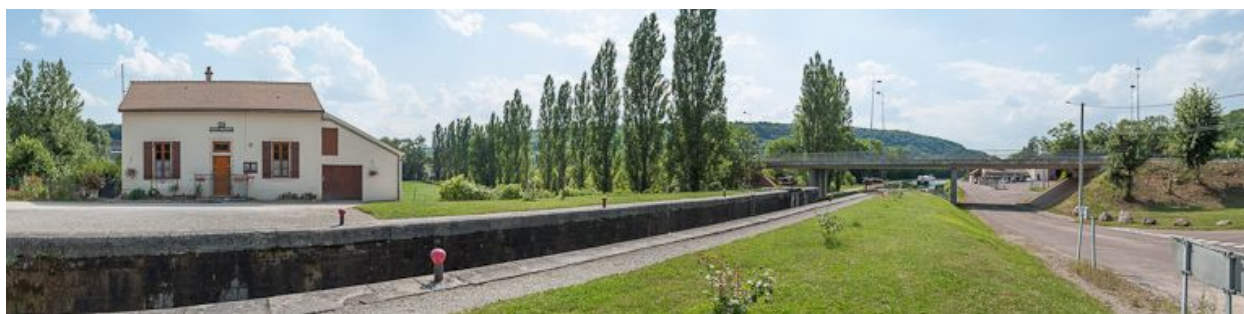
Vue d'ensemble du site d'écluse.
