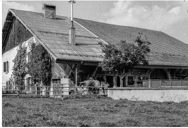
Pignon habitation et gouttereau droit. Phot. Gilbert Poinot IVR43_19752501233Z
