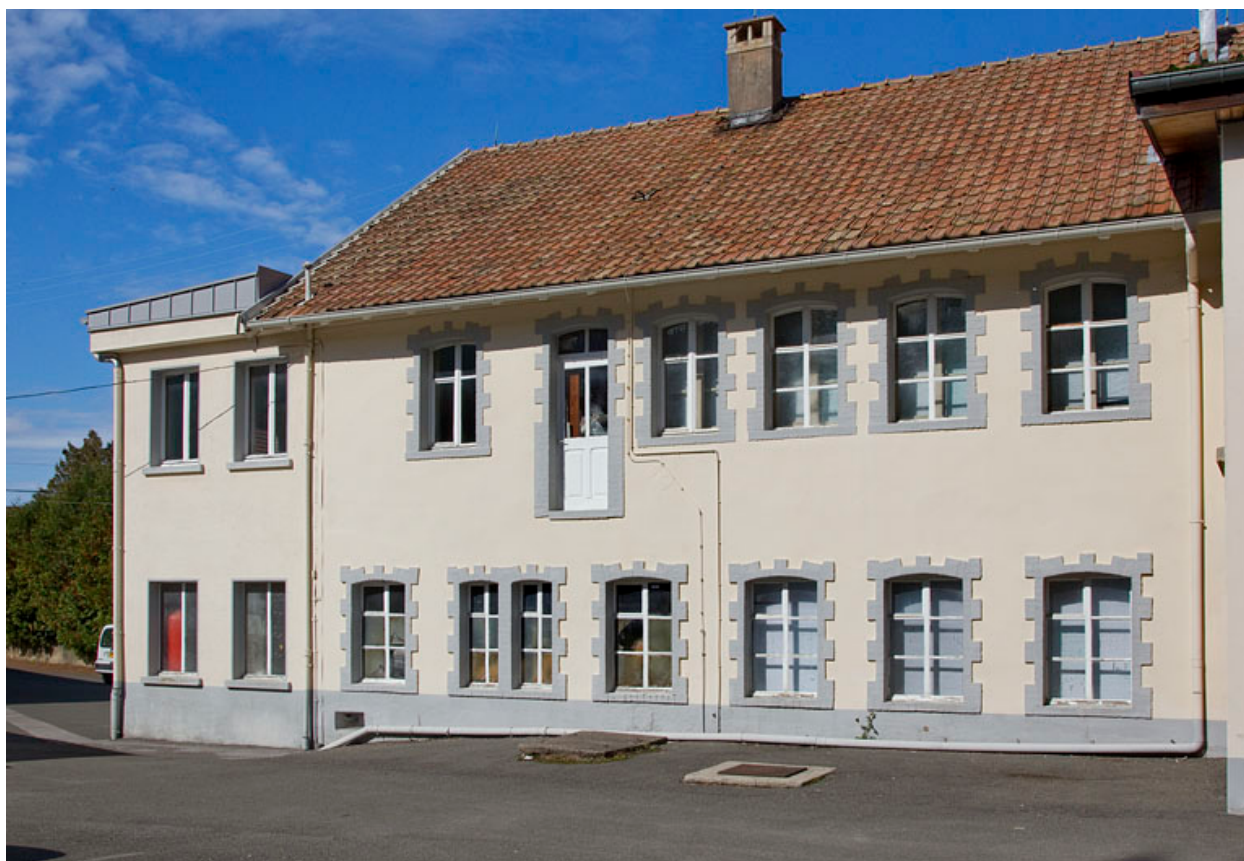
Atelier rehaussé en 1923-1924 : façade latérale droite.
