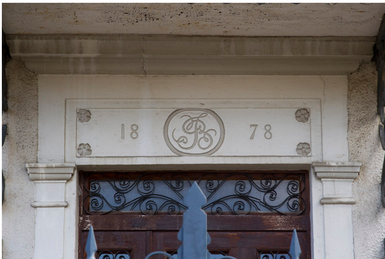
Logement patronal : linteau de la porte d'entrée.
