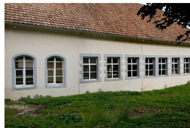
Atelier de 1888, côté pré : détail des fenêtres. Phot. Yves Sancey IVR43_20122502218NUC2A
