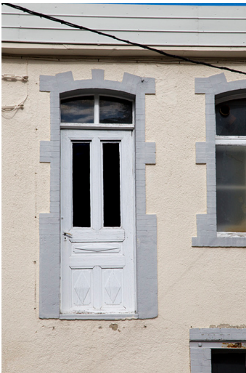
Atelier rehaussé en 1923-1924 : porte haute.
