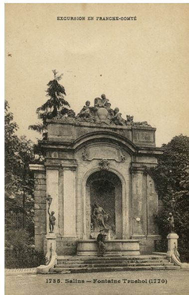
Vue ancienne. Autr. auteur inconnu IVR43_20223900057NUC4A
