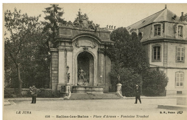
Vue ancienne. Autr. auteur inconnu IVR43_20223900059NUC4A
