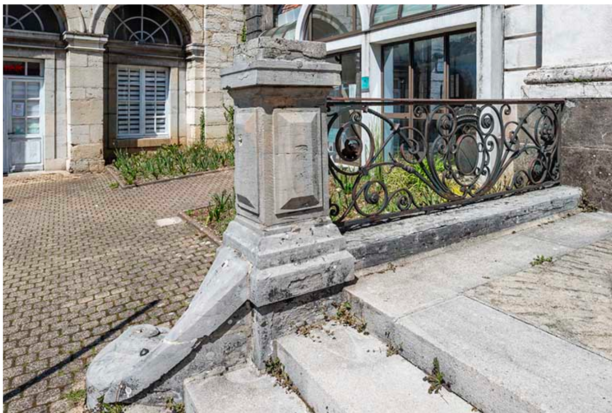
Garde-corps de la partie gauche.
