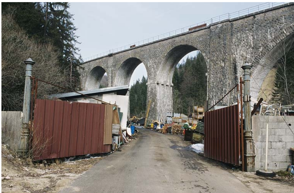
Elévation occidentale (extrémité côté Andelot-en-Montagne), depuis l'ouest.
