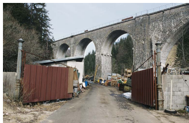
Elévation occidentale (extrémité côté Andelot-en-Montagne), depuis l'ouest.
