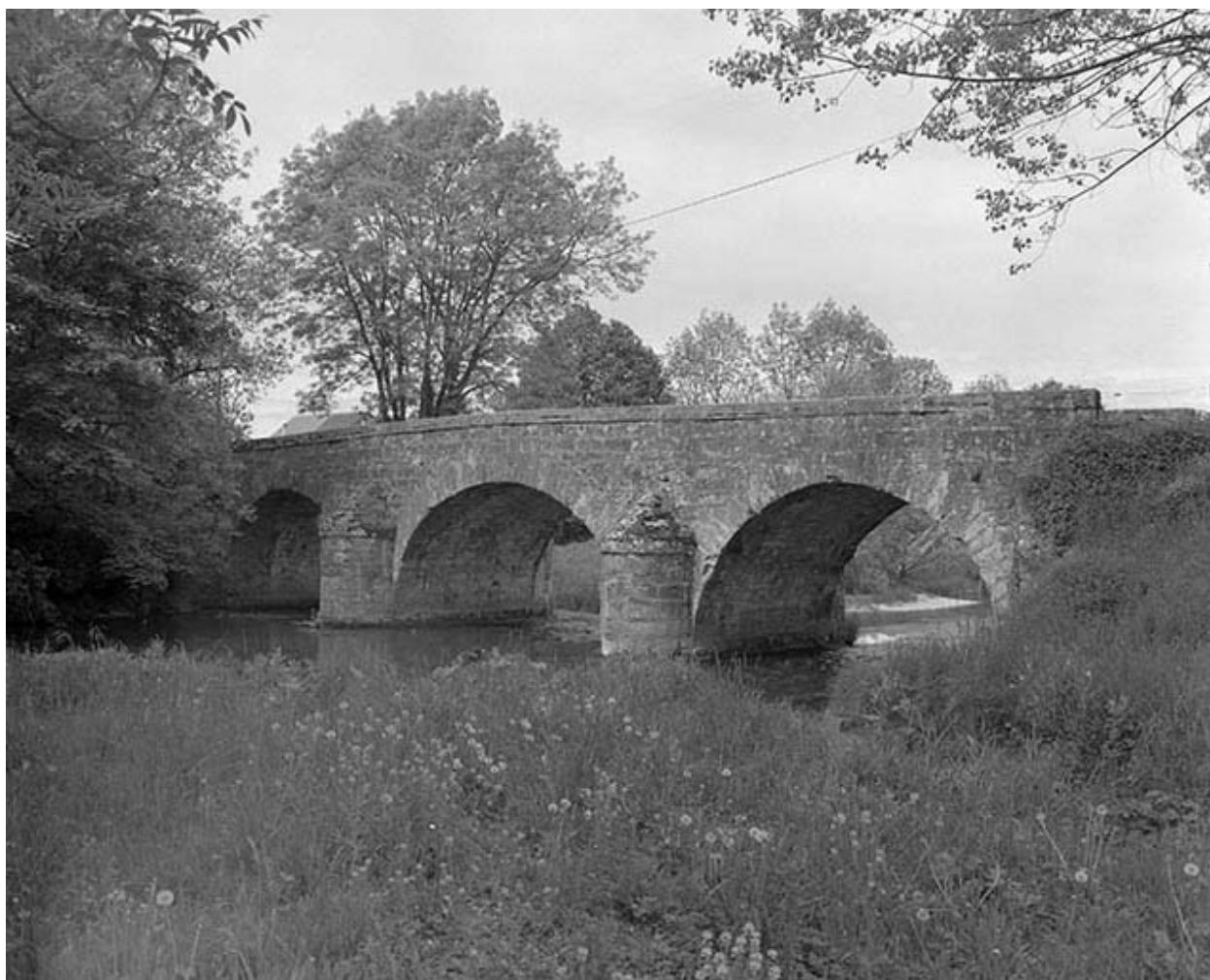
Face amont, vue de trois quarts
