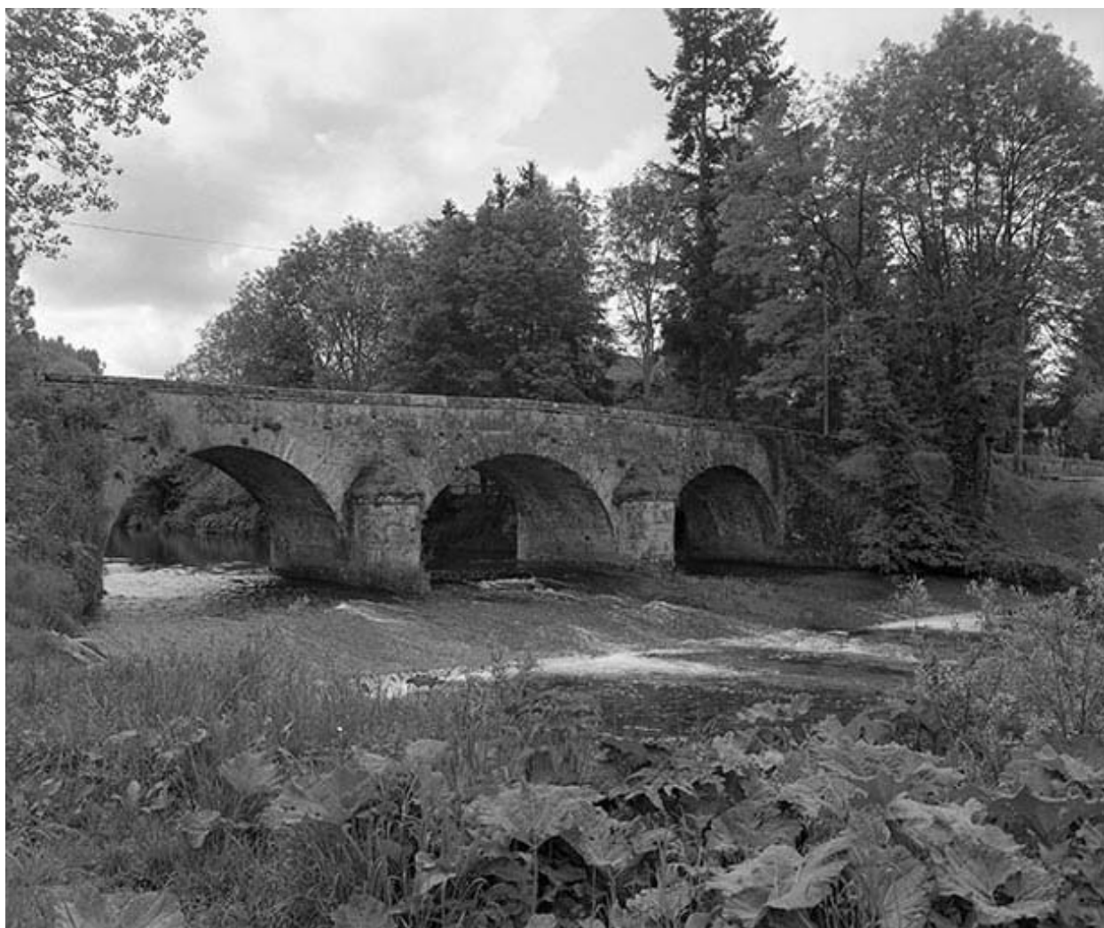
Face aval, vue de trois quarts
