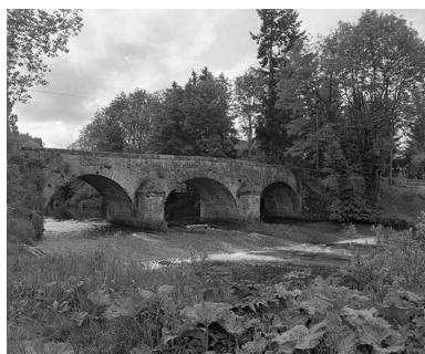
Face aval, vue de trois quarts Phot. Yves Sancey IVR43_19813900071X
