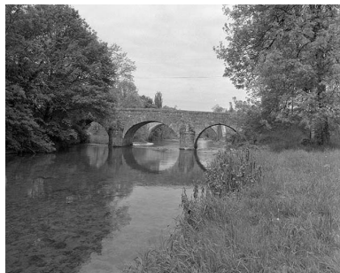
Face amont, vue de face. Phot. Yves Sancey IVR43_19813900073X
