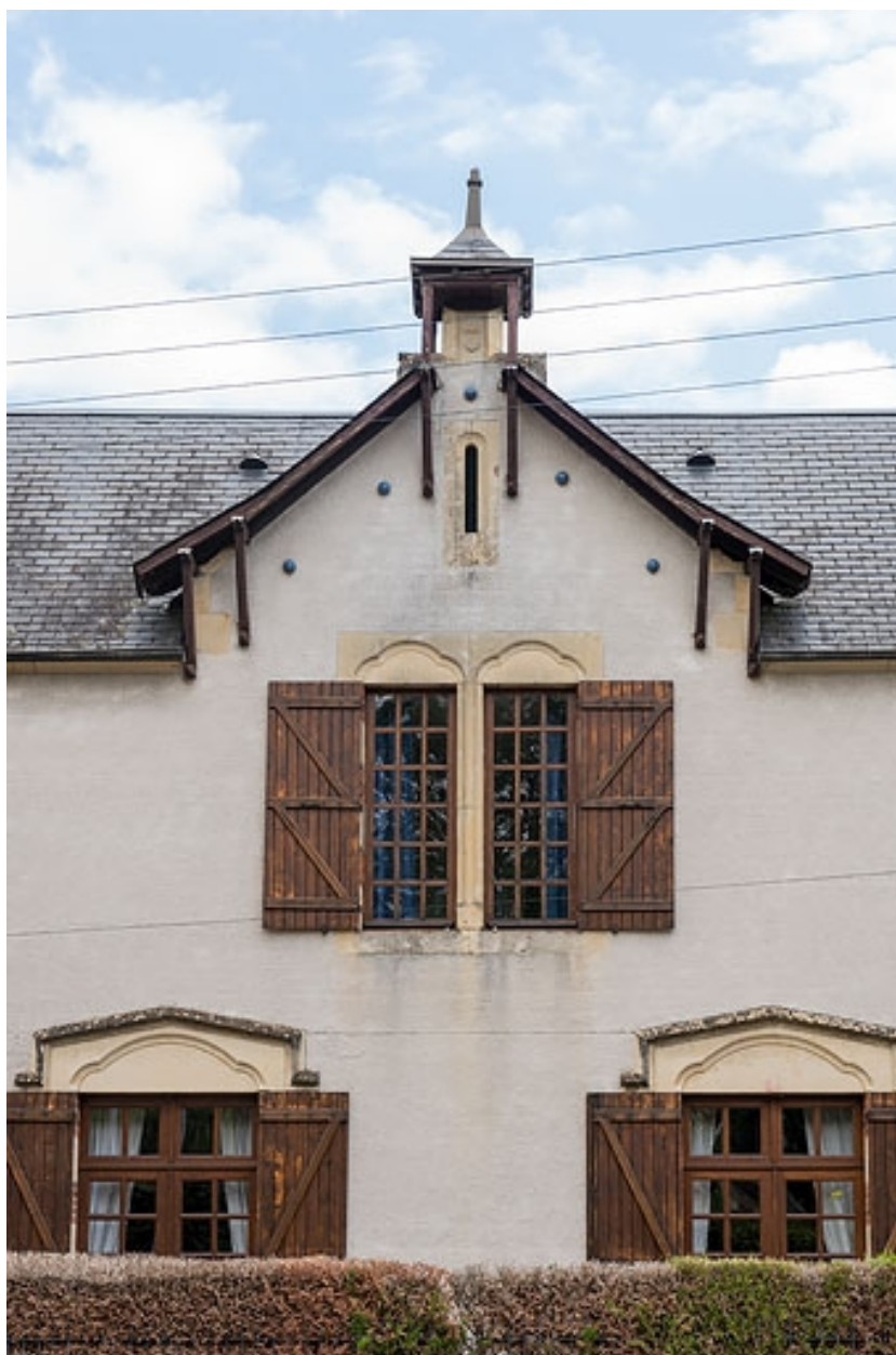
Pignon de la façade principale.
