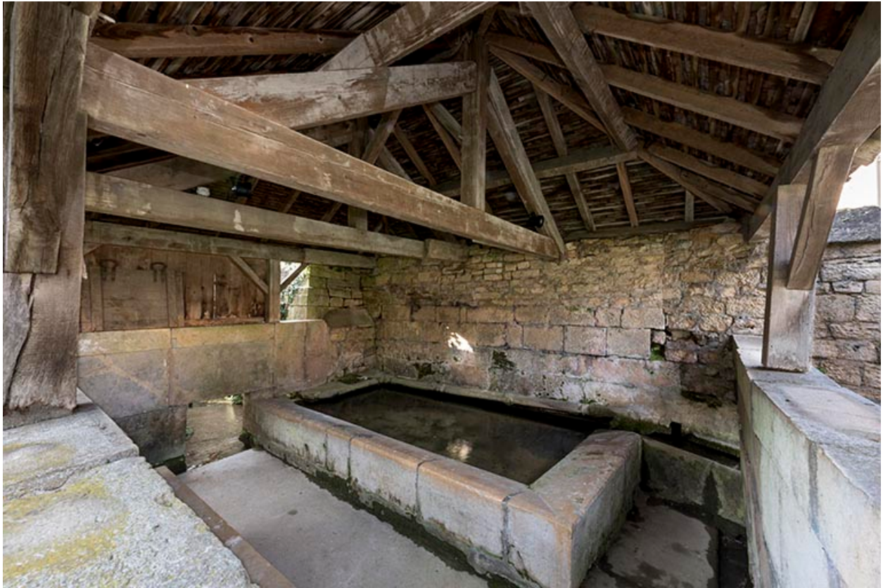
Fontaine-lavoir, 1 rue du Pâquis : intérieur du lavoir.
