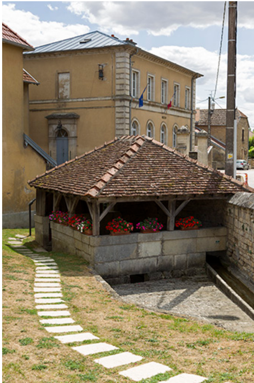
Fontaine-lavoir, 1 rue du Pâquis.
