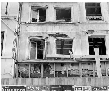
Façade sur rue de la maison de gauche en cours de restauration. Sous les fenêtres se devine une série de guettes en croix de Saint-André. Phot. Jérôme Mongreville IVR43_19882500149X
