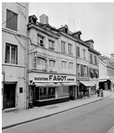
Façades sur rue. Phot. Jérôme Mongreville IVR43_19872500821X
