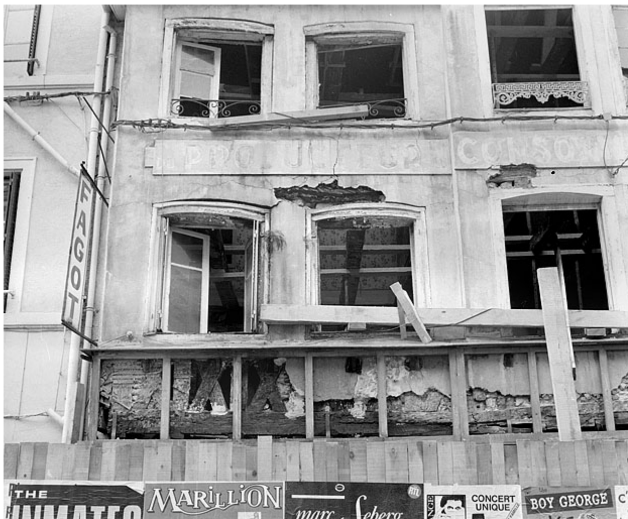
Façade sur rue de la maison de gauche en cours de restauration. Sous les fenêtres se devine une série de guettes en croix de Saint-André.
