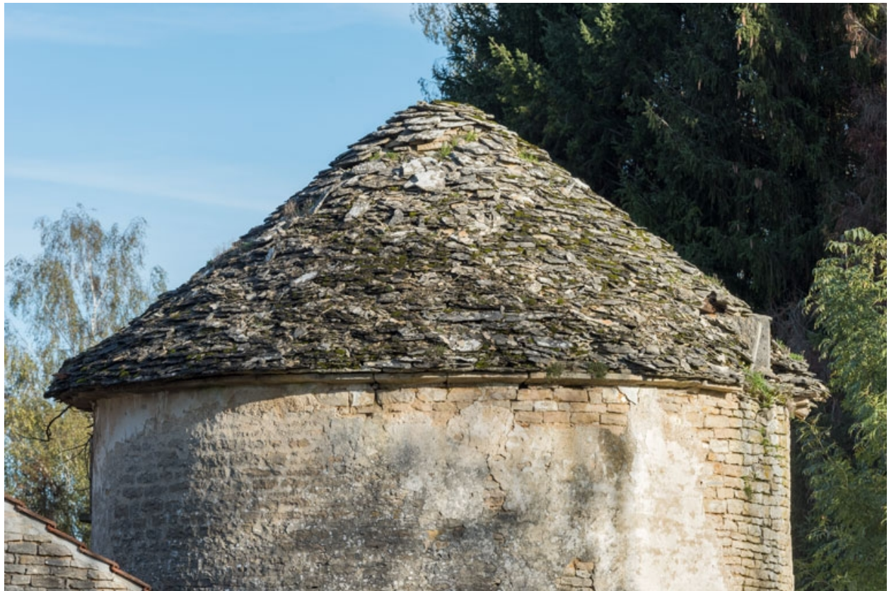
Détail de la toiture depuis le sud.
