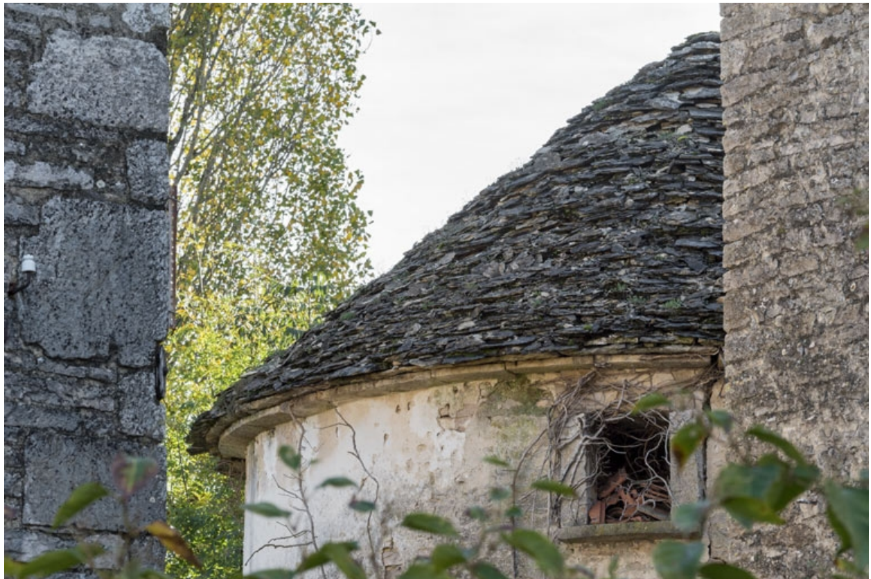
Détail de la toiture depuis le nord.
