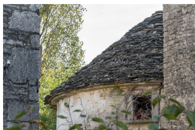
Détail de la toiture depuis le nord. Phot. Pierre-Marie Barbe-Richaud IVR26_20222100953NUC4A
