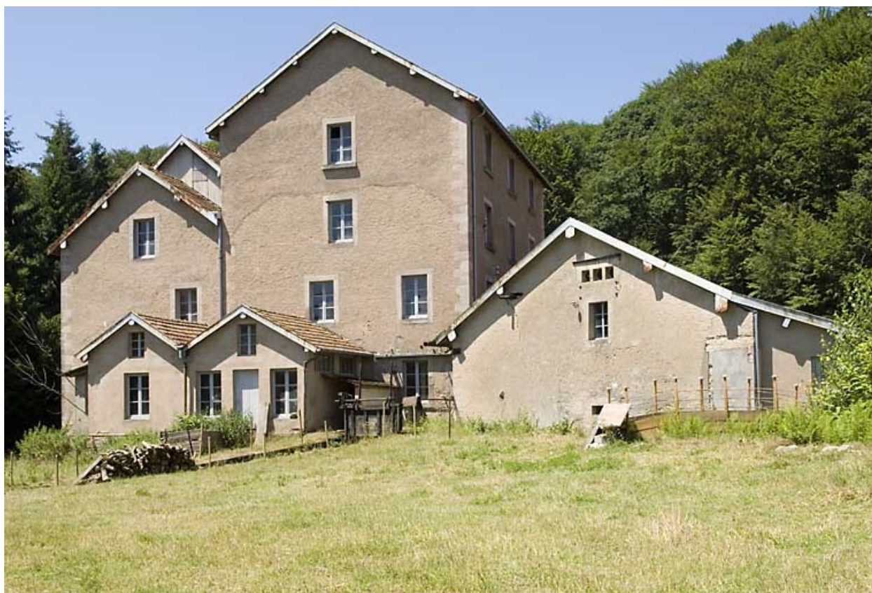
Les façades sud-est.
