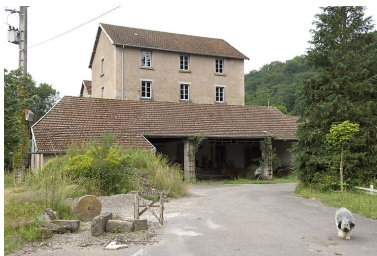
Vue depuis l'est. Phot. Jérôme Mongreville IVR43_20077000334NUCA
