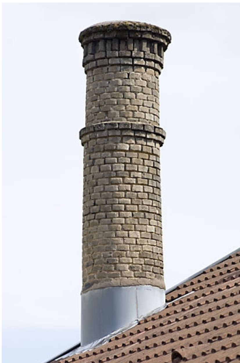
Détail de la souche de la cheminée.
