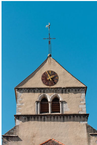
Clocher, élévation postérieure. Phot. Pierre-Marie Barbe-Richaud IVR26_20122101073NUC2A
