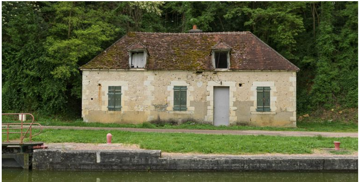
Vue de face de la maison éclusière.
