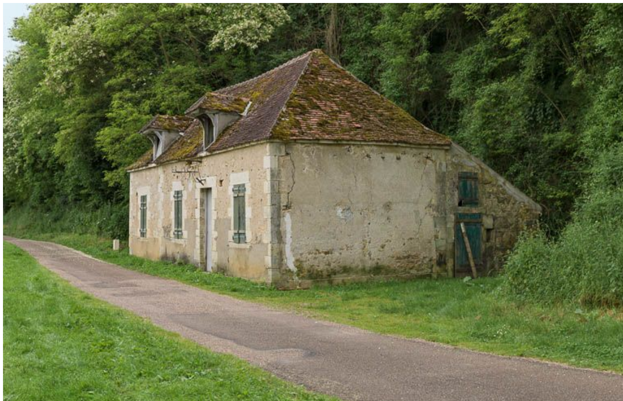
Vue de 3/4 de la maison éclusière.
