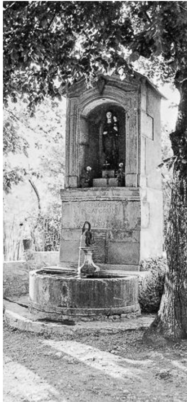
Vue générale, vers 1965. Phot. Dominique Dominguez IVR43_19802500834V
