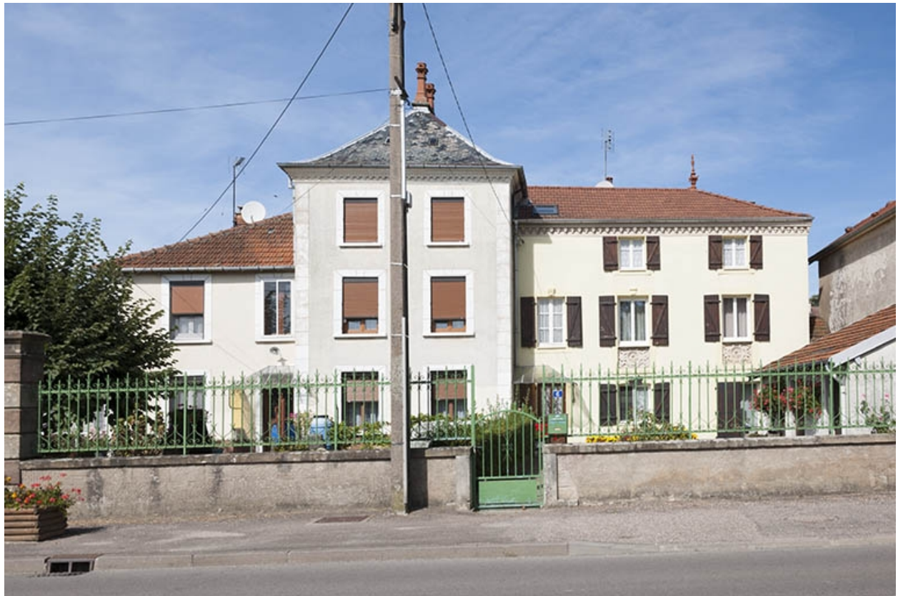
Vue d'ensemble depuis la rue.
