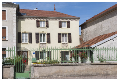
Façade antérieure, partie est. Phot. Jérôme Mongreville IVR43_20137000055NUC4A
