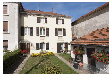
Façade antérieure, partie est. Phot. Jérôme Mongreville IVR43_20137000056NUC4A
